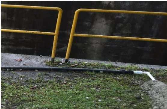
Imagen 42. Manguera conexión con tubería de abastecimiento
