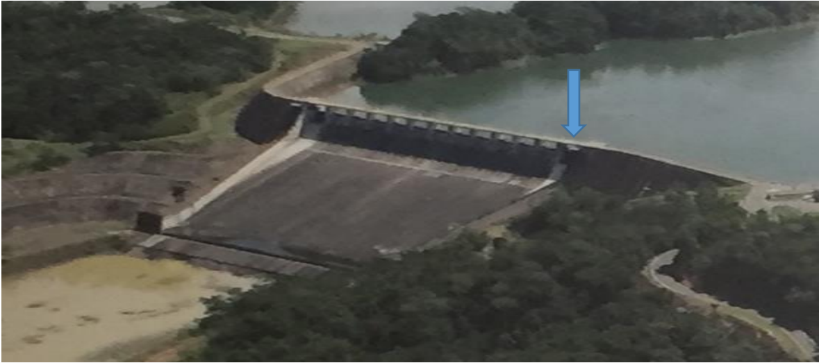
Imagen 11. Ingreso por el rebosadero a PAD (Punto de Adquisición de Datos)
