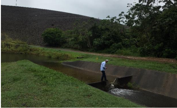
Imagen 17. Vertedero Trapezoidal de la Presa
