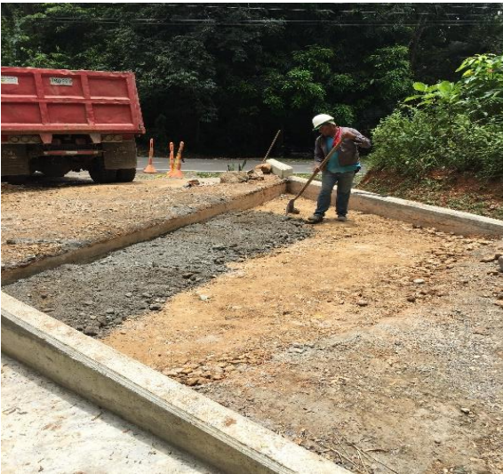
Imagen 29. Compactación y Extendida de mezcla
