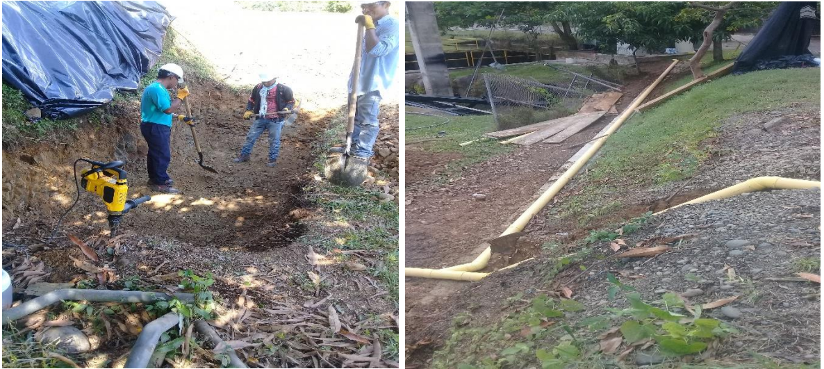
Imagen 35. Excavaciones, instalación de tuberías sanitarias para sistema séptico
