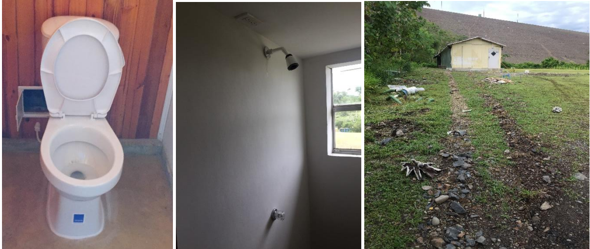
Imagen 43. Elementos sanitarios y Cubrimiento de zanjas para tubería
