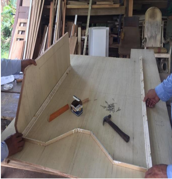
Imagen 37. Construcción de formaleta
