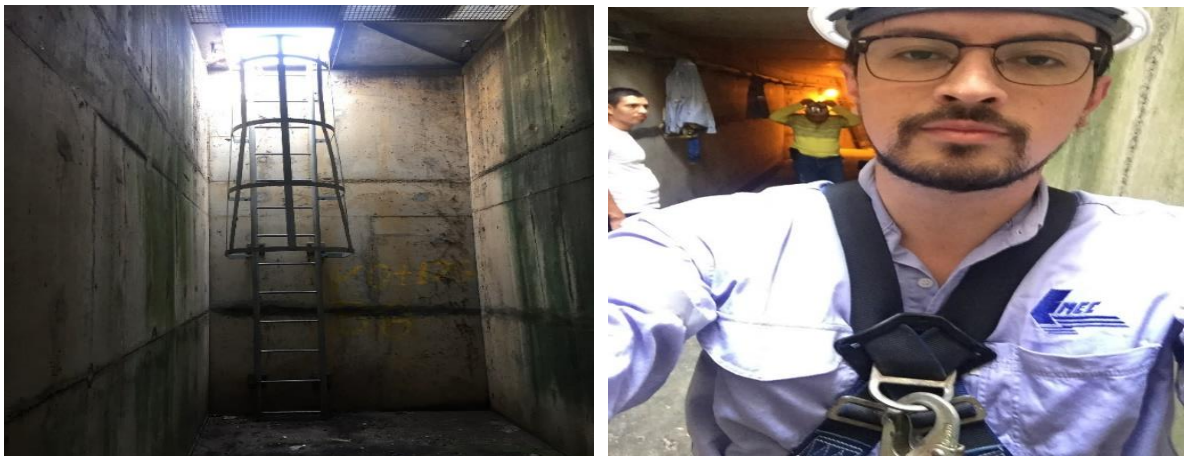
Imagen 14. Ingreso a estructura de rebosadero
