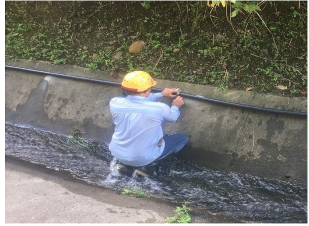
Imagen 41. Perforación lateral del canal y ubicación de manguera
