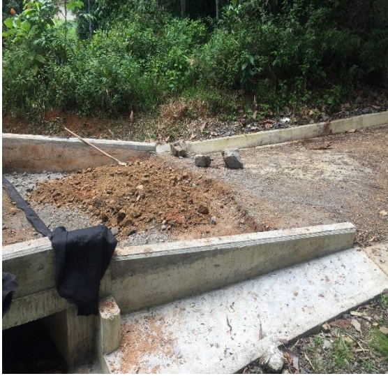
Imagen 28. Compactación de material
