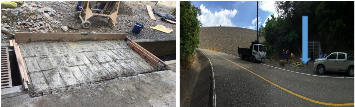
Imagen 38. Construcción placa de ampliación
