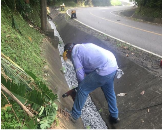
Imagen 41. Perforación lateral del canal y ubicación de manguera
