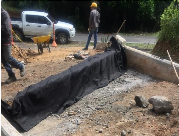
Imagen 26. Geotextil de recubrimiento
