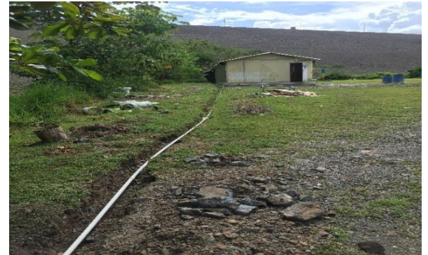
Imagen 42. Manguera conexión con tubería de abastecimiento
