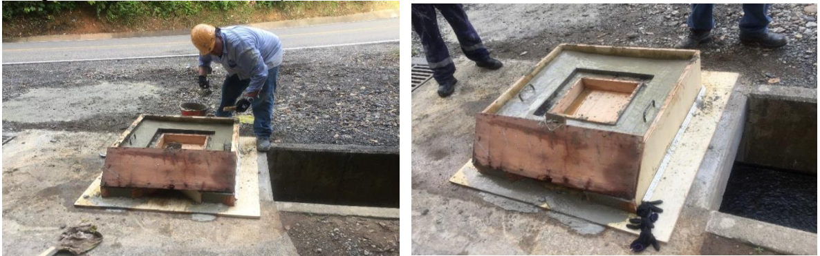
Imagen 39. Estructura de captación
