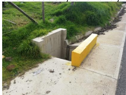
Imagen 6. . Obras de drenaje en la vía Tunja- Chivatá.
