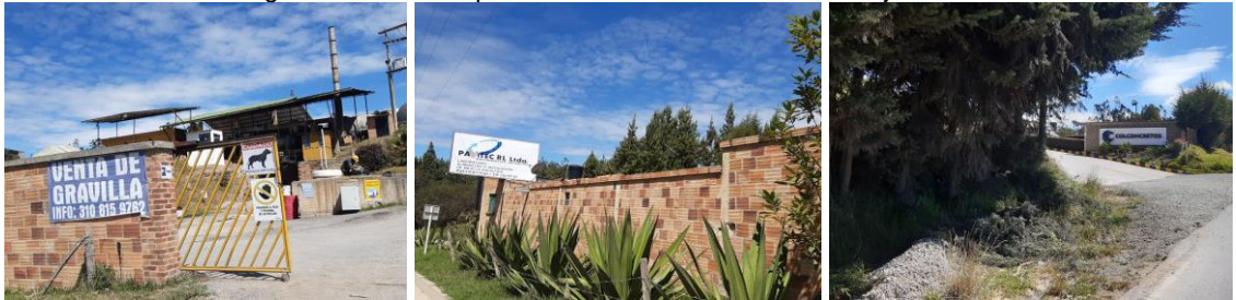
Imagen 4. Plantas de producción de asfalto en la vía Tunja- Chivatá.
