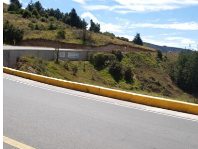
Imagen 5. Obras de estabilización de taludes en la vía Tunja- Chivatá.
