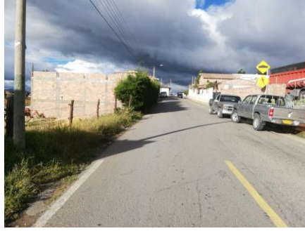
Imagen 15. Estado final de la vía Tunja- Chivatá.
