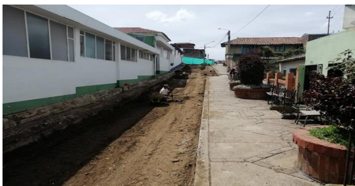
Figura 36. Relleno con material común compactado.
