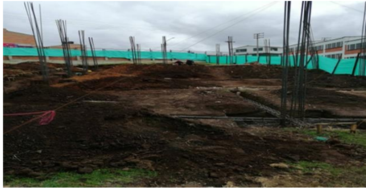
Figura 8. Acero de refuerzo cimentación y columnas.
