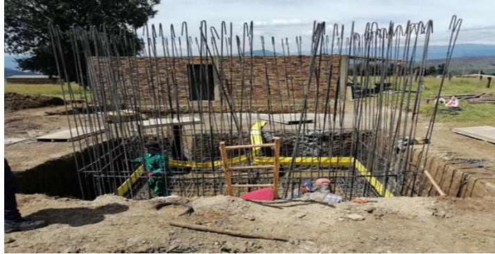
Figura 17. Acero de refuerzo sedimentador.
