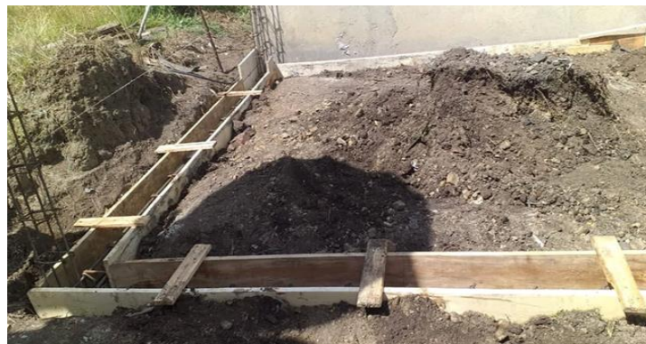
Figura 30. Cimentación mejoramientos de vivienda.
