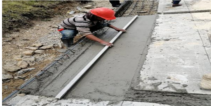
Figura 3. Proceso constructivo placa huella.
