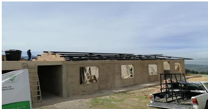
Figura 14. Instalación cubierta metálica.
