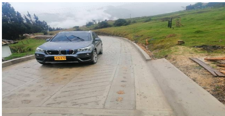
Figura 6. Entrega oficial de la obra a la comunidad.
