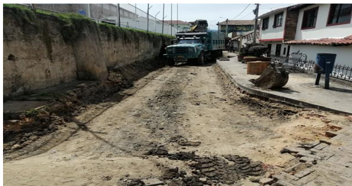
Figura 34. Excavación y demolición adoquín deteriorado.
