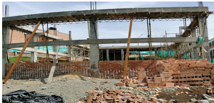
Figura 11. Sistema estructural de la edificación e inicio de construcción de la mampostería.
