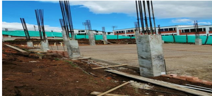
Figura 10. Instalación malla electro soldada y columnas fundidas en primera sección.
