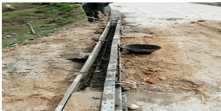
Figura 5. Proceso constructivo bordillo (sardinell).
