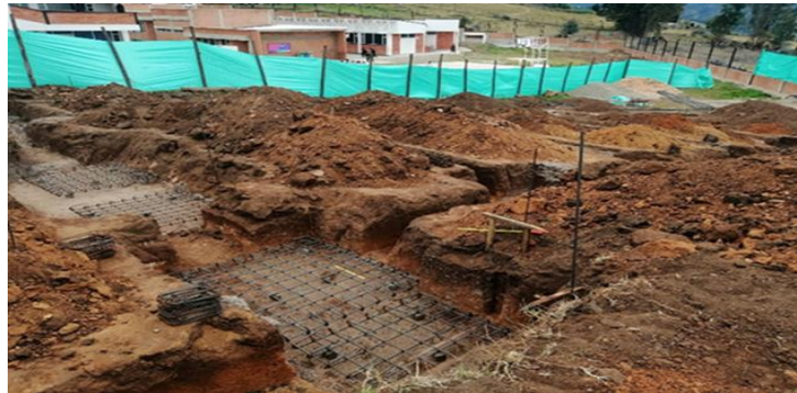
Figura 7. Excavación mecánica y manual de la obra.
