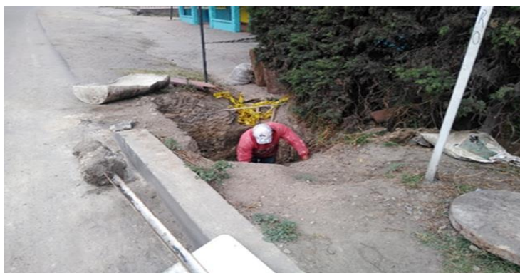
Figura 22. Optimización pozo de inspección.
