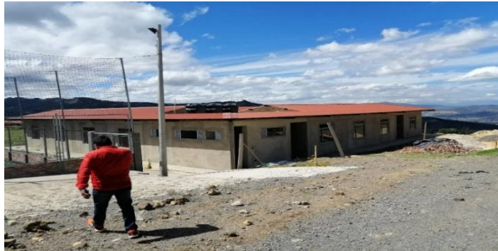
Figura 15. Avance de la obra terminado el año 2019.
