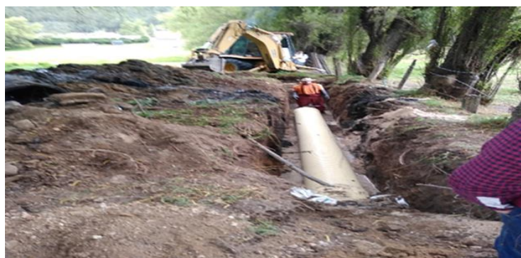
Figura 21. Instalación tubería nueva.
