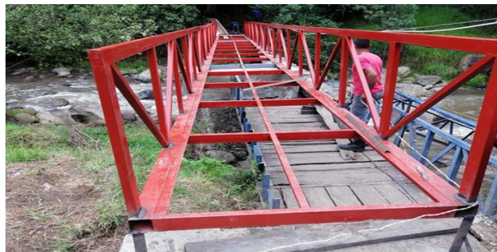
Figura 25. Ensamble puente metálico.
