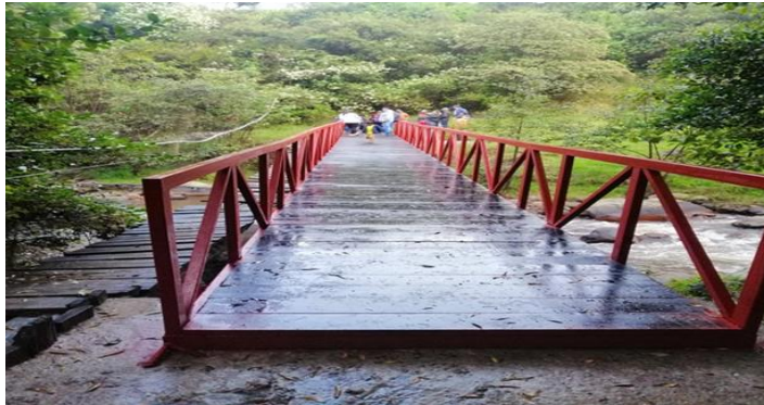
Figura 26. Puente metálico con acabados.
