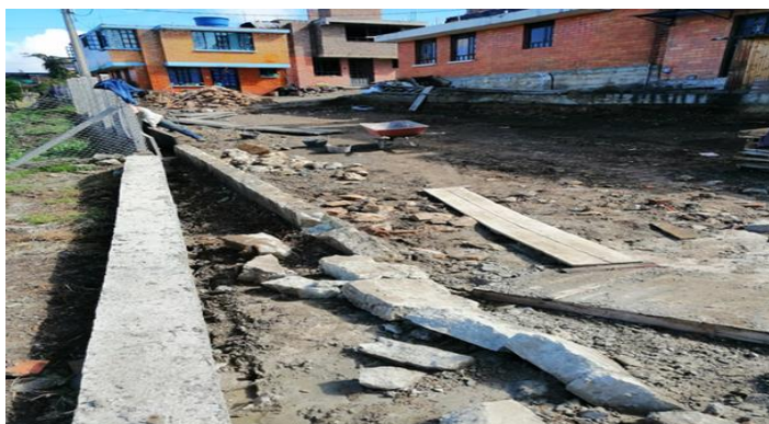
Figura 27. Descapote capa vegetal.
