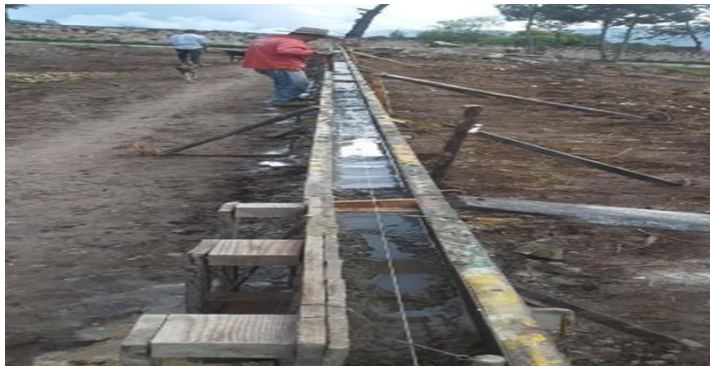
Figura 28. Fundida de concreto de bordillos.
