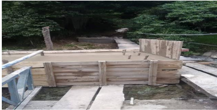
Figura 24. Bases en concreto reforzado.
