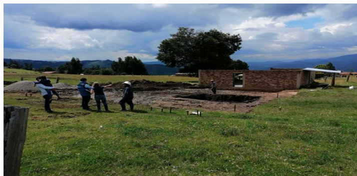
Figura 16. Ubicación y excavación estructuras hidráulicas.
