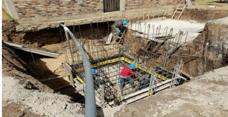
Figura 19. Acero de refuerzo floculador.
