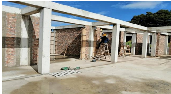
Figura 12. Inicio de la mampostería de la obra.
