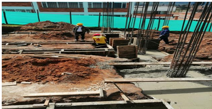
Figura 9. Fundida de concreto premezclado en la cimentación.
