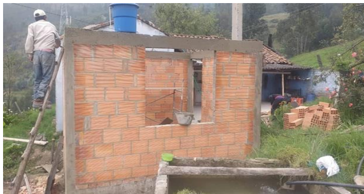
Figura 31. Estructura con mampostería.
