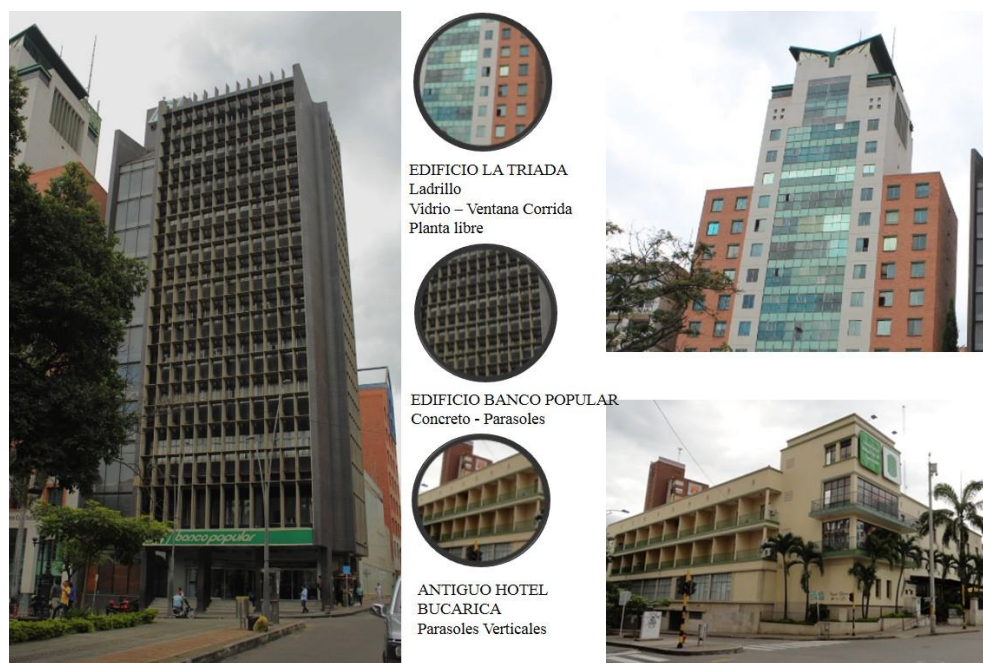
Figura 41. Identificación de los principios brutalistas en algunos de los edificios de la zona centro de la ciudad de Bucaramanga, Colombia.
