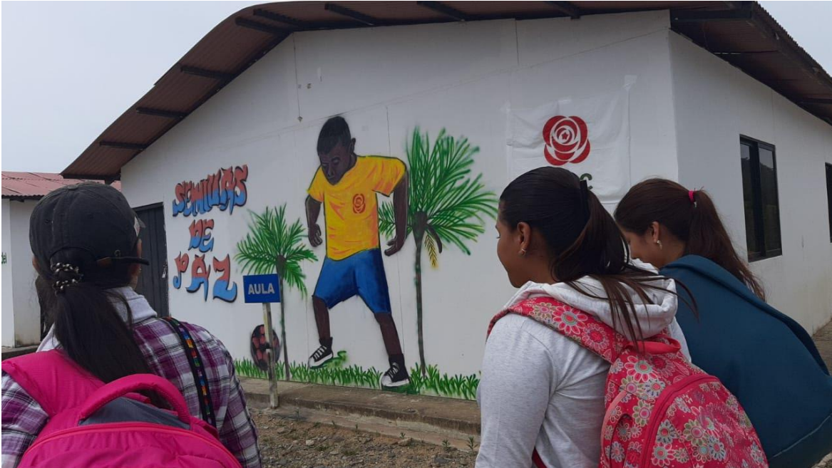
Figura 8 Infraestructura ETCR John Bautista Peña
