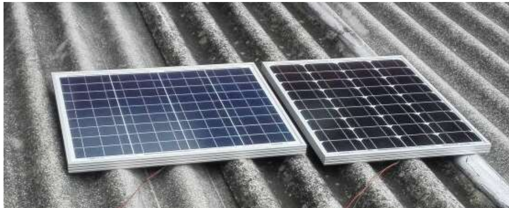
Figura 38 Puesta de Paneles solares
