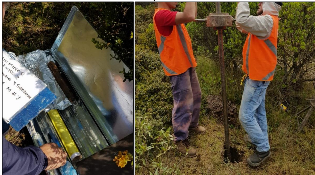
Ilustración 5 Ensayos SPT en Centro 2
