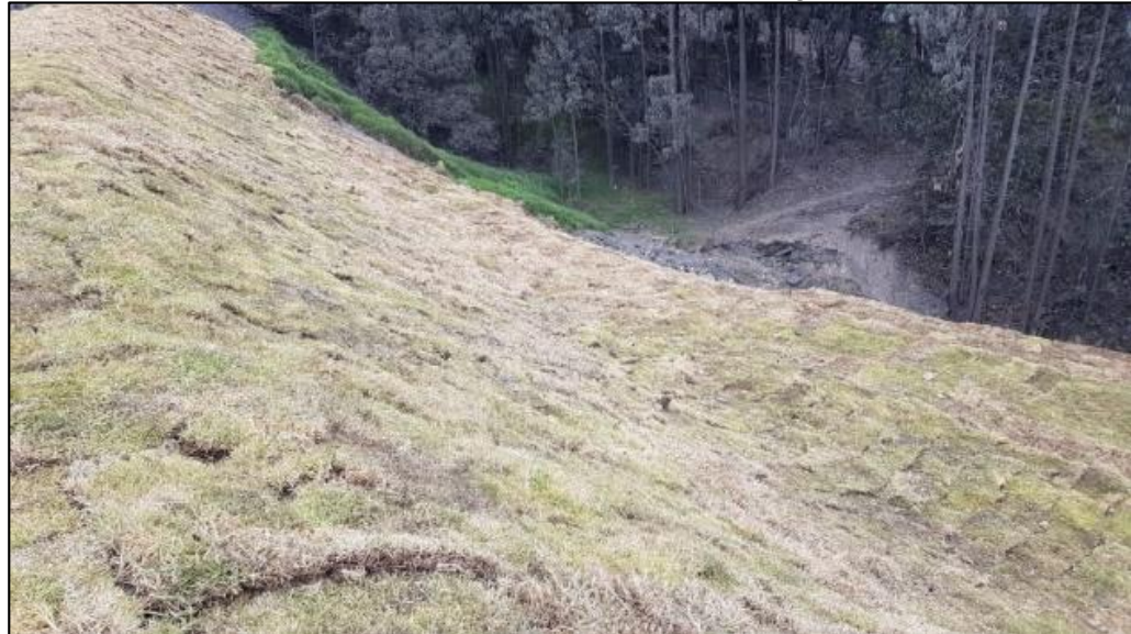
Ilustración 4 Talud con cobertura vegetal
