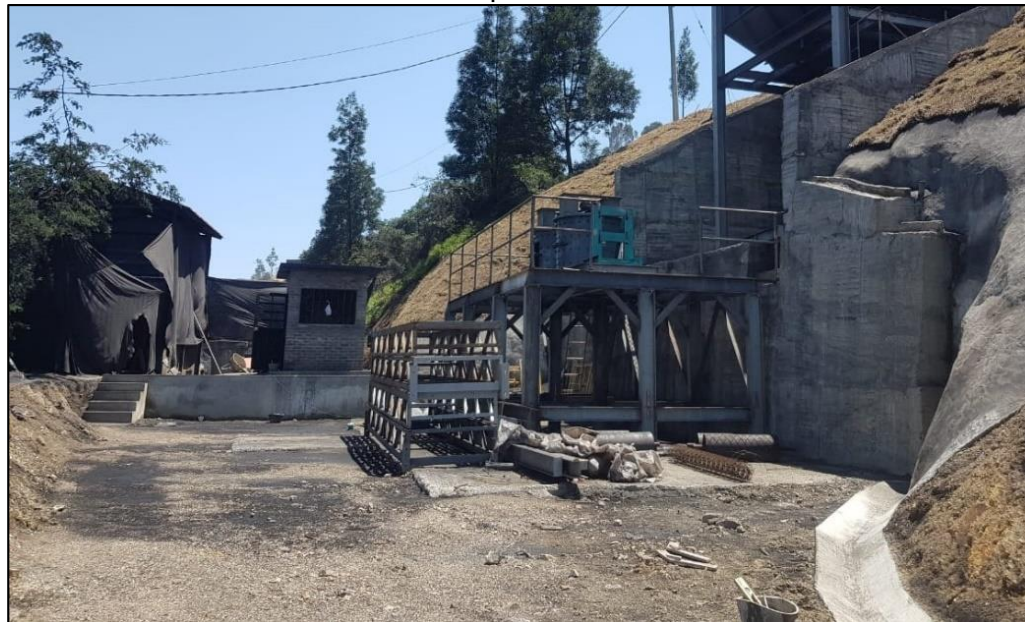
Ilustración 14 Caseta panel de control de Molino
