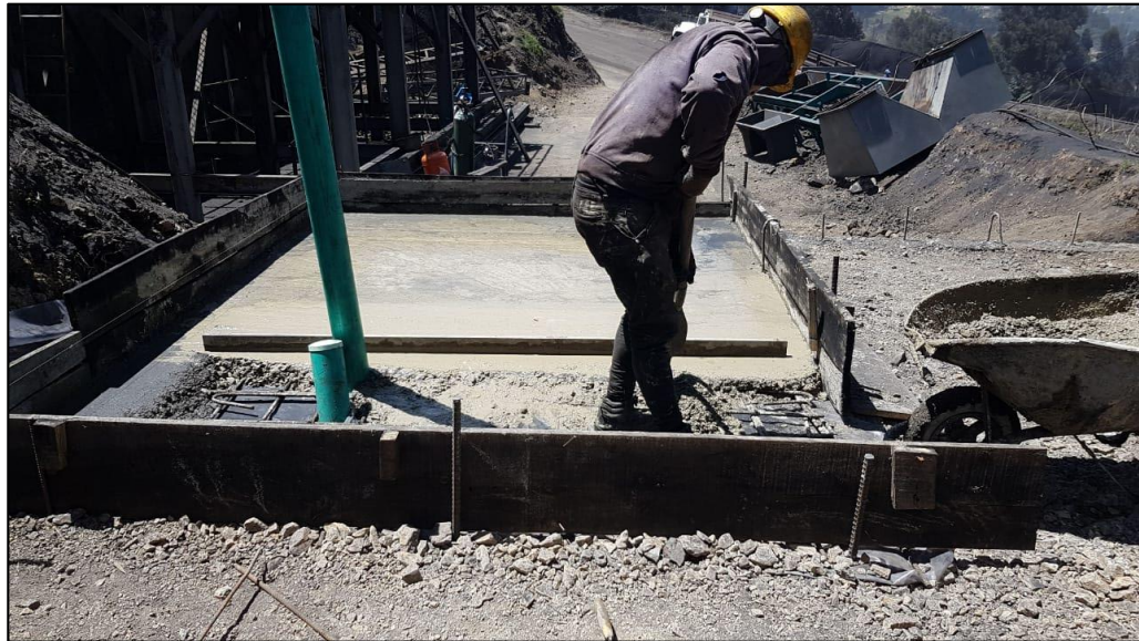
Ilustración 13 Placa de cimentación
