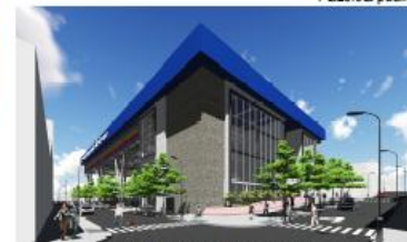
Fachada carrera 19 con calle 34
