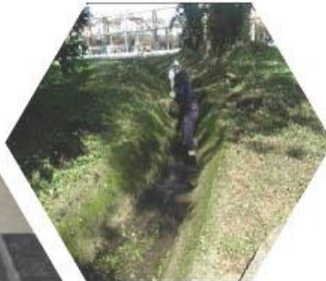
LIMPIEZA DE CUNETAS – PUERTO SALGAR
