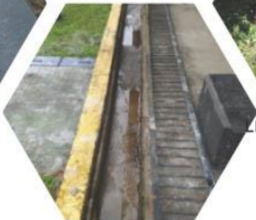
LIMPIEZA DE CANALES AGUA LLUVIA – BUENAVENTURA
