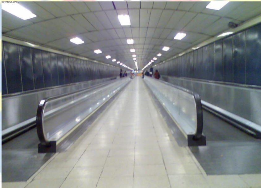
Ilustración 7 Banda transportadora Metro de Madrid, España
