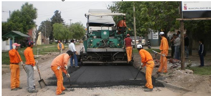
Fig. 3: Extensión de capa de asfalto
