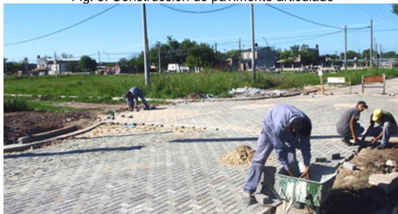
Fig. 5: Construcción de pavimento articulado
