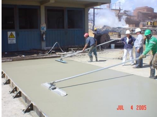
Fig. 4: Afinado del concreto para pavimentos
