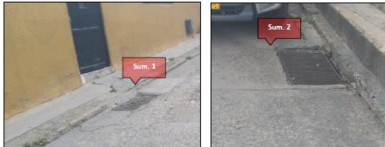
Figura 19. Estructuras hidráulicas presentes en la vía de estudio del barrio Jordán. Fuente. Propia
