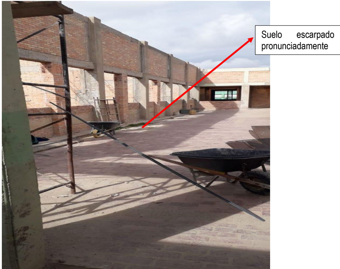
Figura 21. Patio interior módulo 2 Colegio Silvino Rodríguez sede manzanares. Fuente: propia
