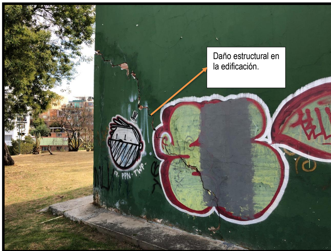
Figura 5. Registro fotográfico del salón comunal barrio Maldonado. Fuente: autor.
