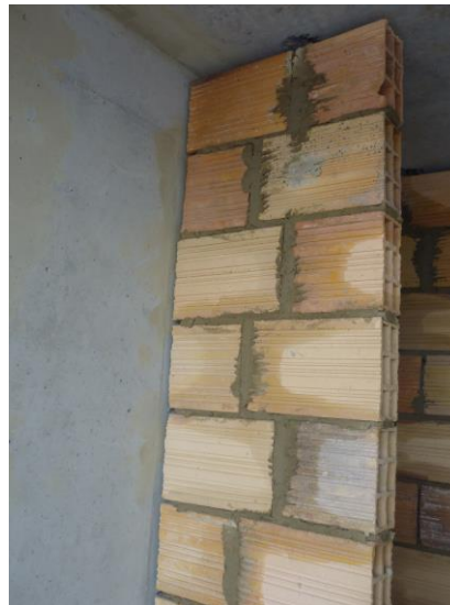
Ilustración 10 Muro Mampostería
