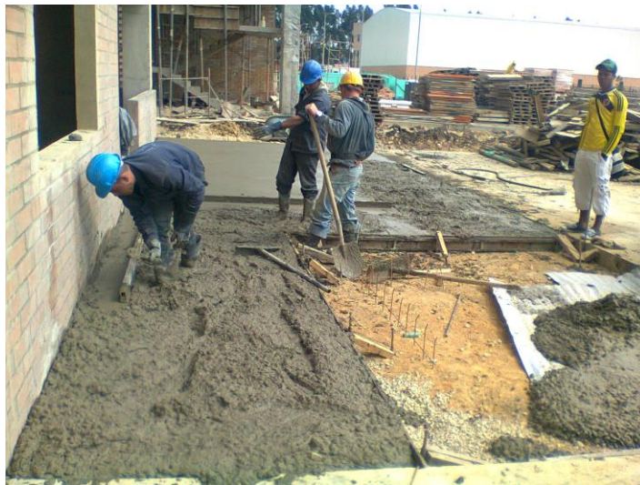
Ilustración 13 Fundida de placa (foto de ejemplo)
