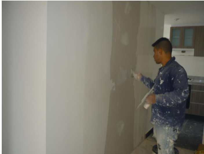
Ilustración 26 Empastado de muros. (foto de ejemplo)
