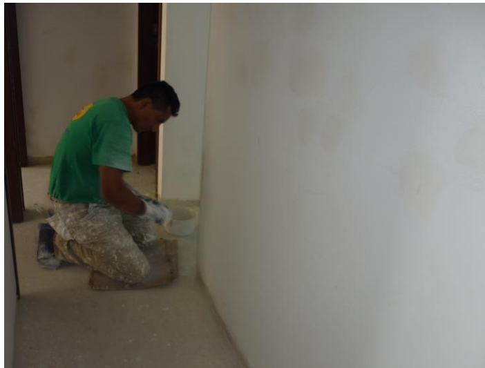
Ilustración 25 Resane de muros (foto de ejemplo)
