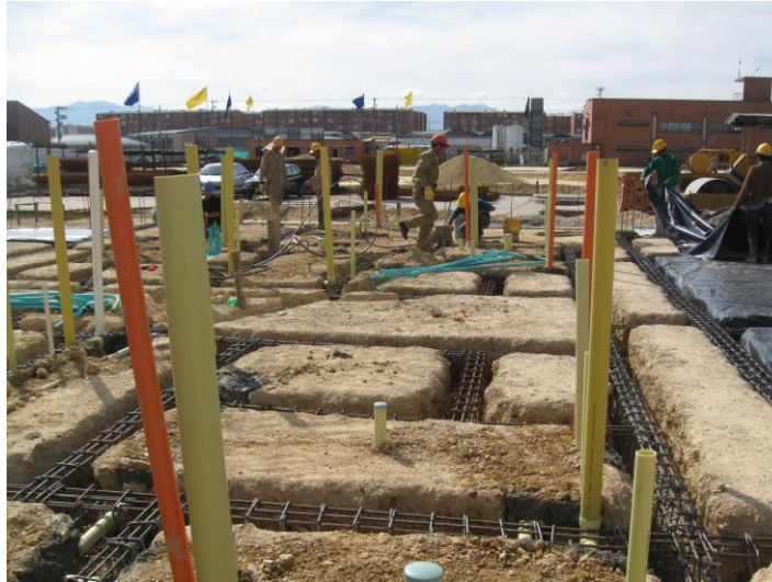
Ilustración 20 Prolongación de Desagües (foto de ejemplo)
