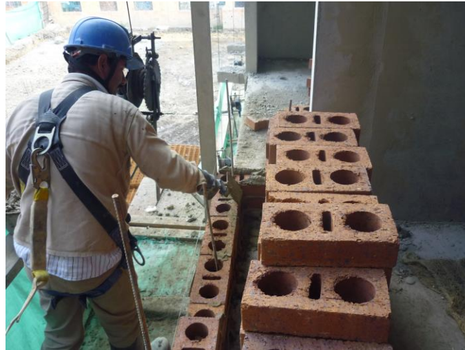
Ilustración 9 Forme muros (foto de ejemplo)
