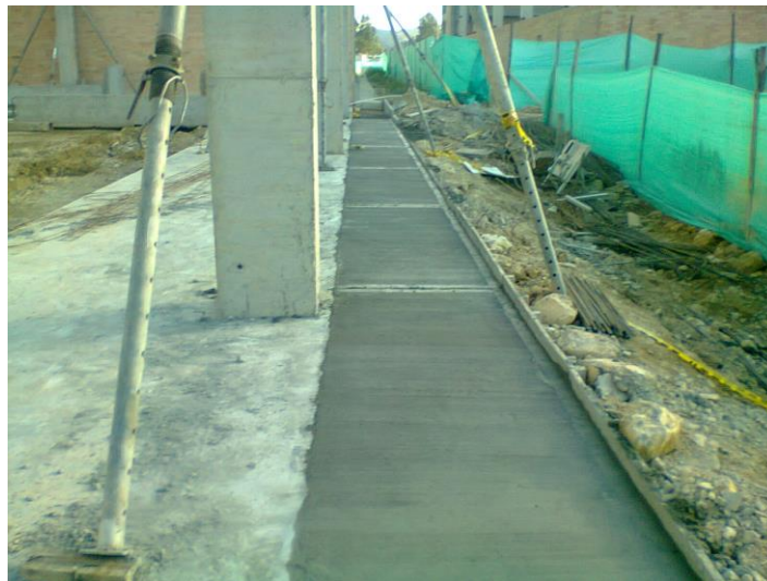
Ilustración 28 Escobillado y Gualiado en Anden (foto de ejemplo)
