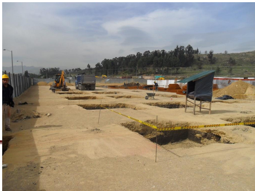
Ilustración 7 Excavaciones (foto de ejemplo)
