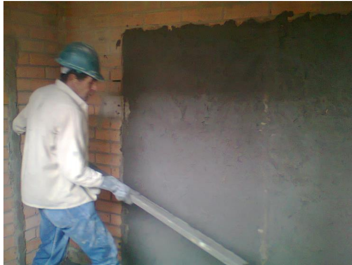
Ilustración 11 Pañete en Muros (foto de ejemplo)
