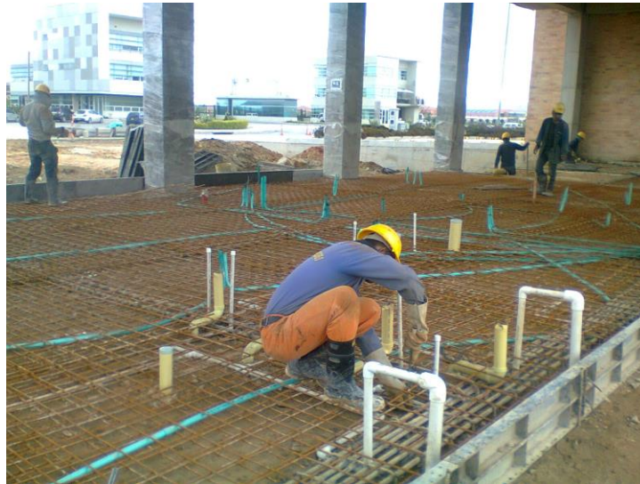
Ilustración 19 Conexión de tendido Hidráulico (foto de ejemplo)
