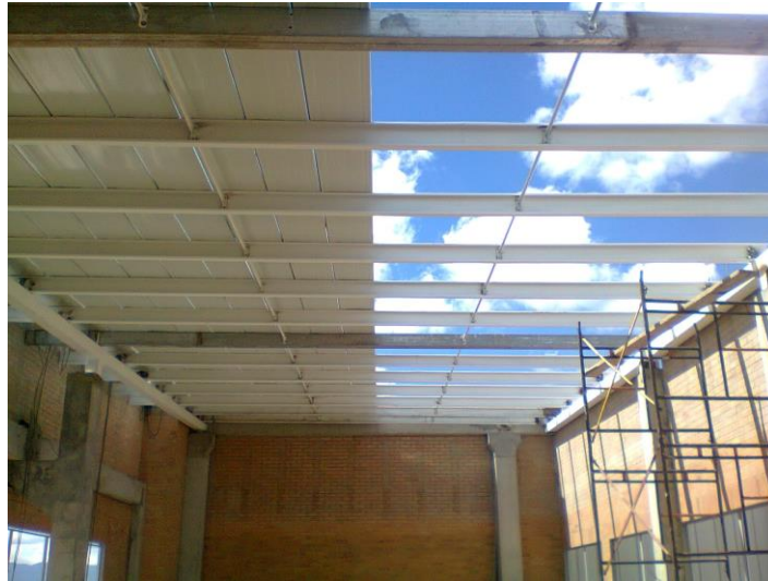
Ilustración 15 Instalación de cubierta (foto de ejemplo)
