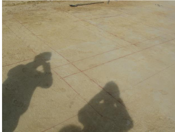
Ilustración 6 Replanteo (foto de ejemplo)
