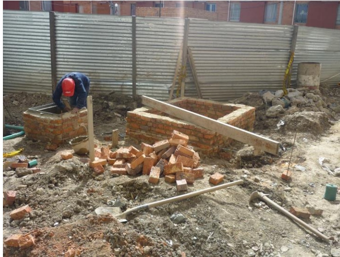
Ilustración 21 Construcción de cajas de inspección (foto de ejemplo)
