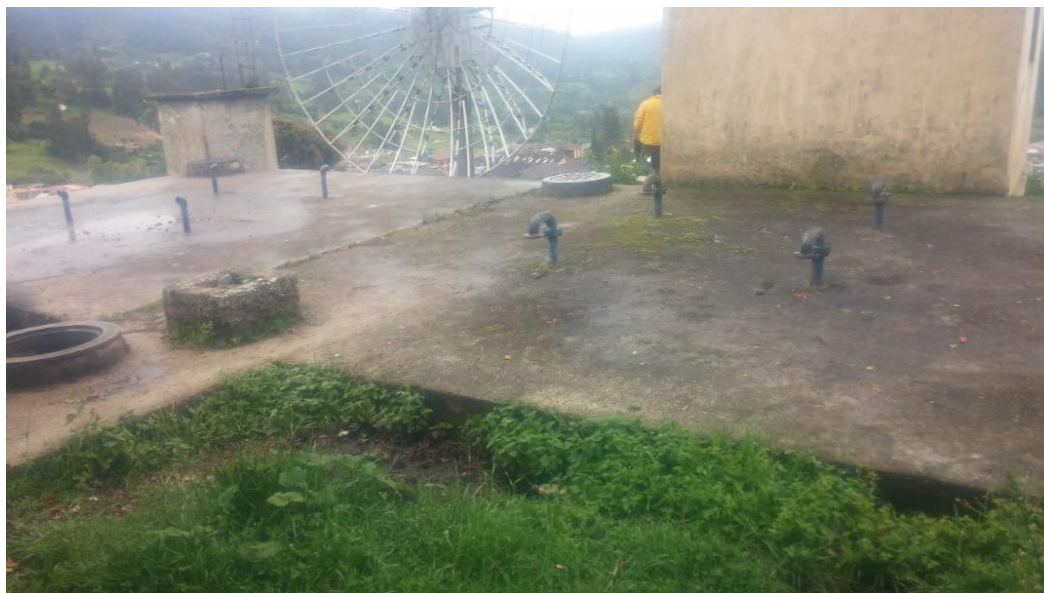
Figura 18. Tanques de almacenamiento.
