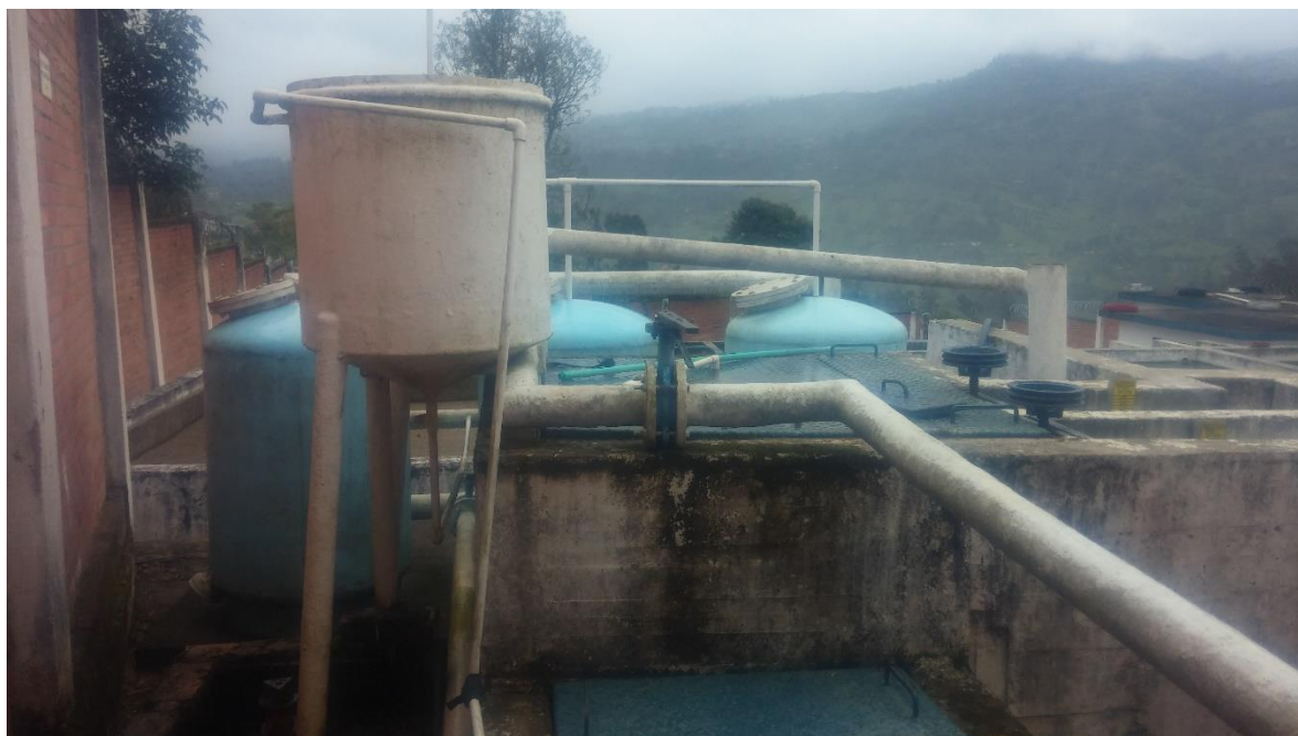
Figura 13. Mejoramiento de pH con cal.
