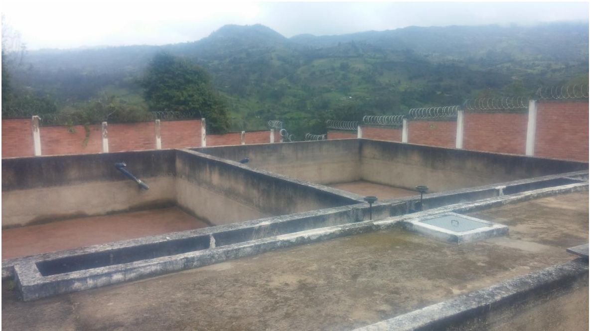
Figura 15. Filtración lenta en arena.
