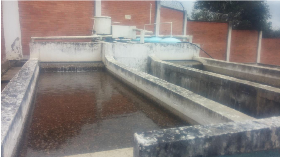
Figura 14. Filtración rápida en grava.
