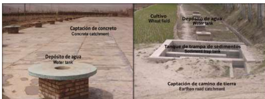
Figura 7. Tanques de almacenamiento de agua distribuidos en el campo de trigo para riego complementario. Fuente: Yan Li, 2003.
