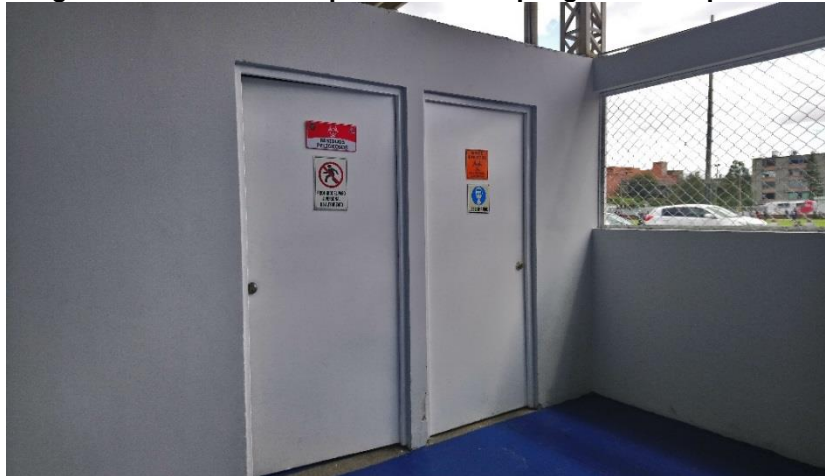
Imagen 14. Centro de acopio. Desechos peligrosos hospitalarios.
