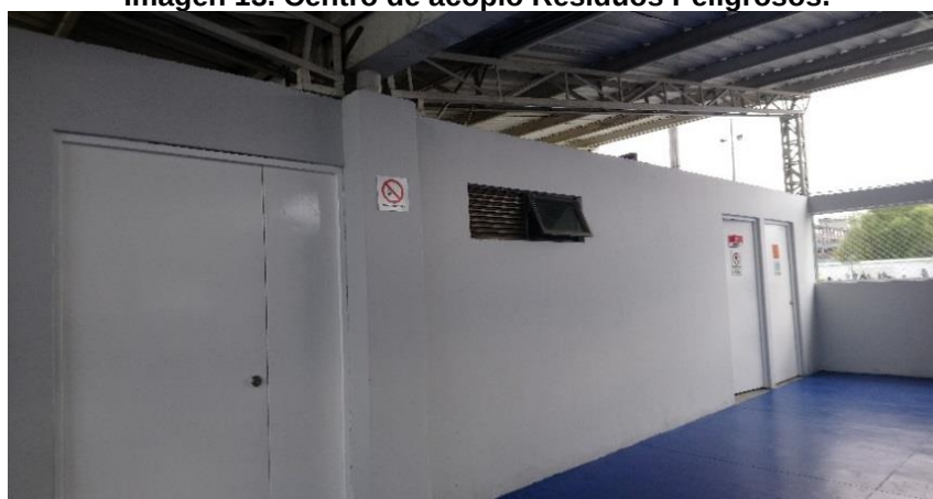
Imagen 13. Centro de acopio Residuos Peligrosos.
