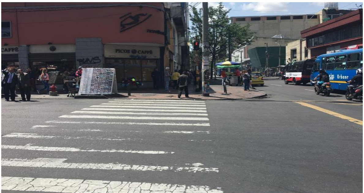
Ilustración 10: Vista al sur esquina calle 63 con carrera 13, falta de señalización vertical. Fuente propia.
