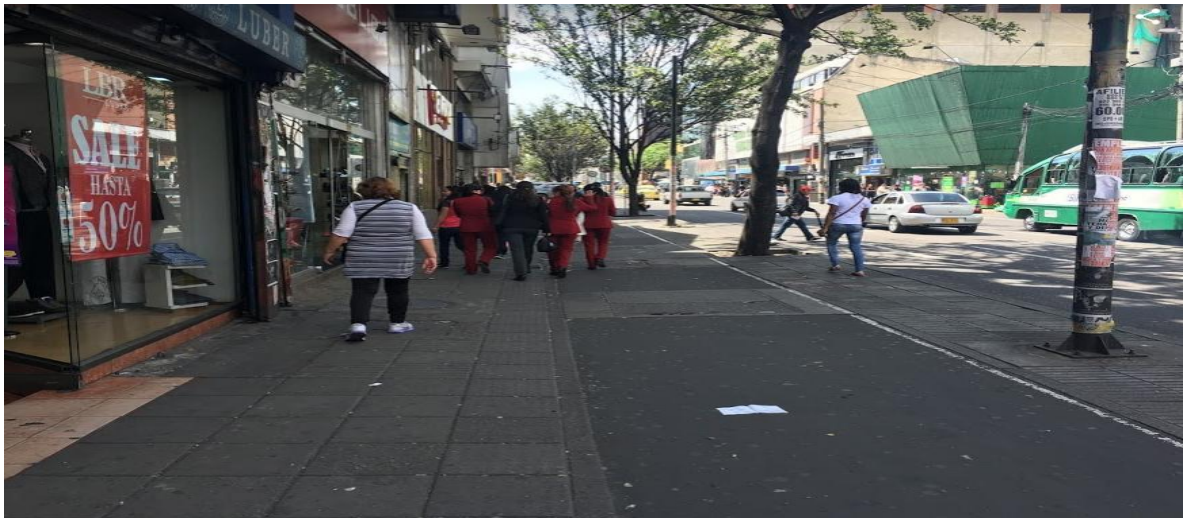
Ilustración 8: Tramo 12 (calle 62 y 63). Pavimento sin demarcación. Fuente propia.
