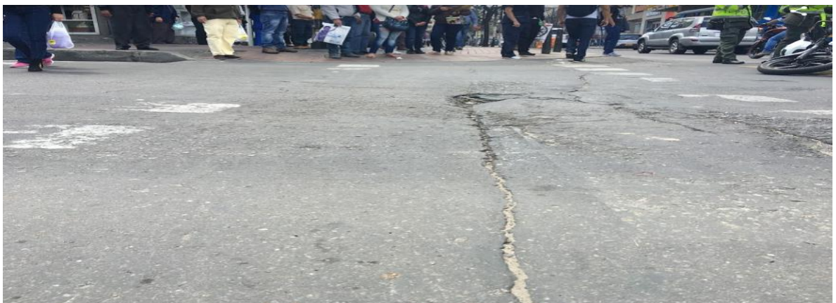
Ilustración 12: Estado actual de la intersección calle 51 con carrera 13. Fuente propia.
