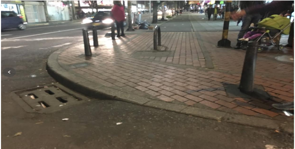
Ilustración 16: Problemática intersección calle 57 con carrera 13. Fuente propia.
