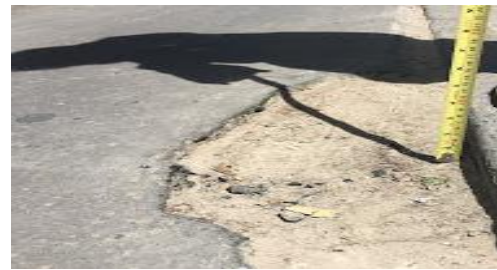
Bache con una profundidad a aproximadamente 5.3 cm en carpeta asfáltica del ciclocarril.
