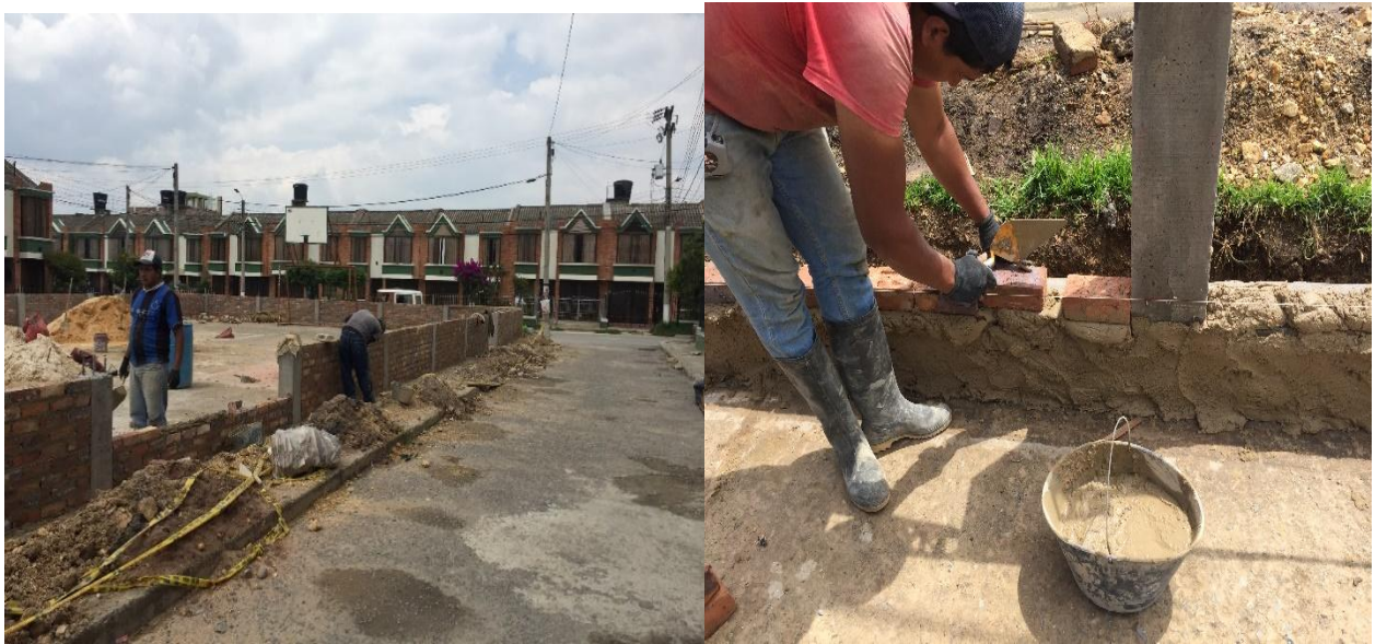
Imagen 13. Construcción de muro tolete común.
