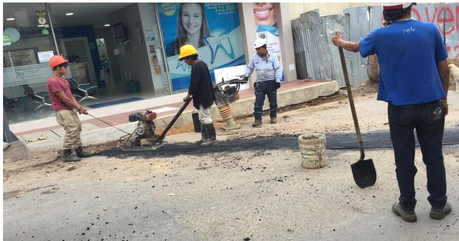
Imagen 24. Extendido y compactación carpeta asfáltica parcheo
