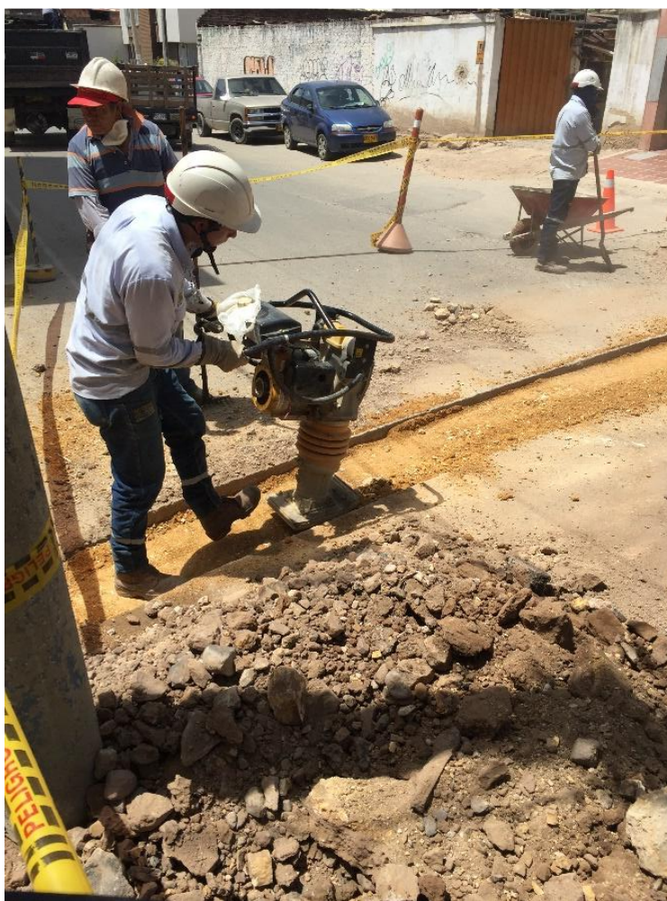
Imagen 22. Alistado carpeta base, nuevo material afirmado
