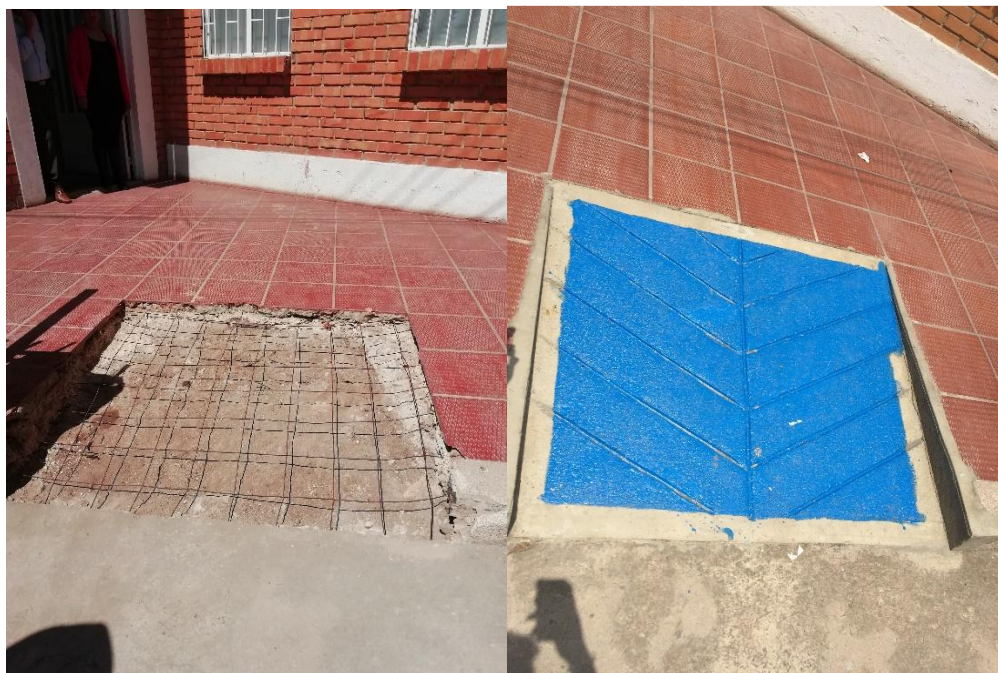
Imagen 6. Alistado del terreno, inclusión de malla electro soldada y culminación de rampa
