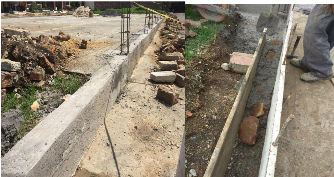
Imagen 11. Construcción de viga de amarre
