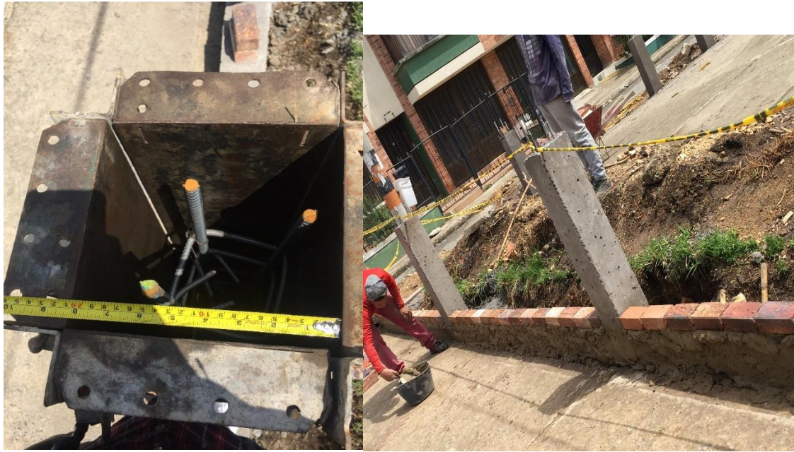
Imagen 12. Construcción columnas
