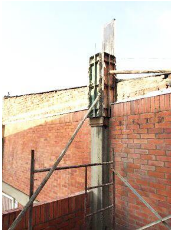
Imagen 15. Construcción de columnas polideportivo la gruta
