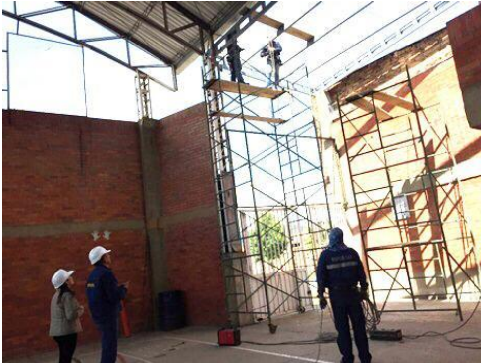
Imagen 16. Ampliación cubierta polideportivo la gruta
