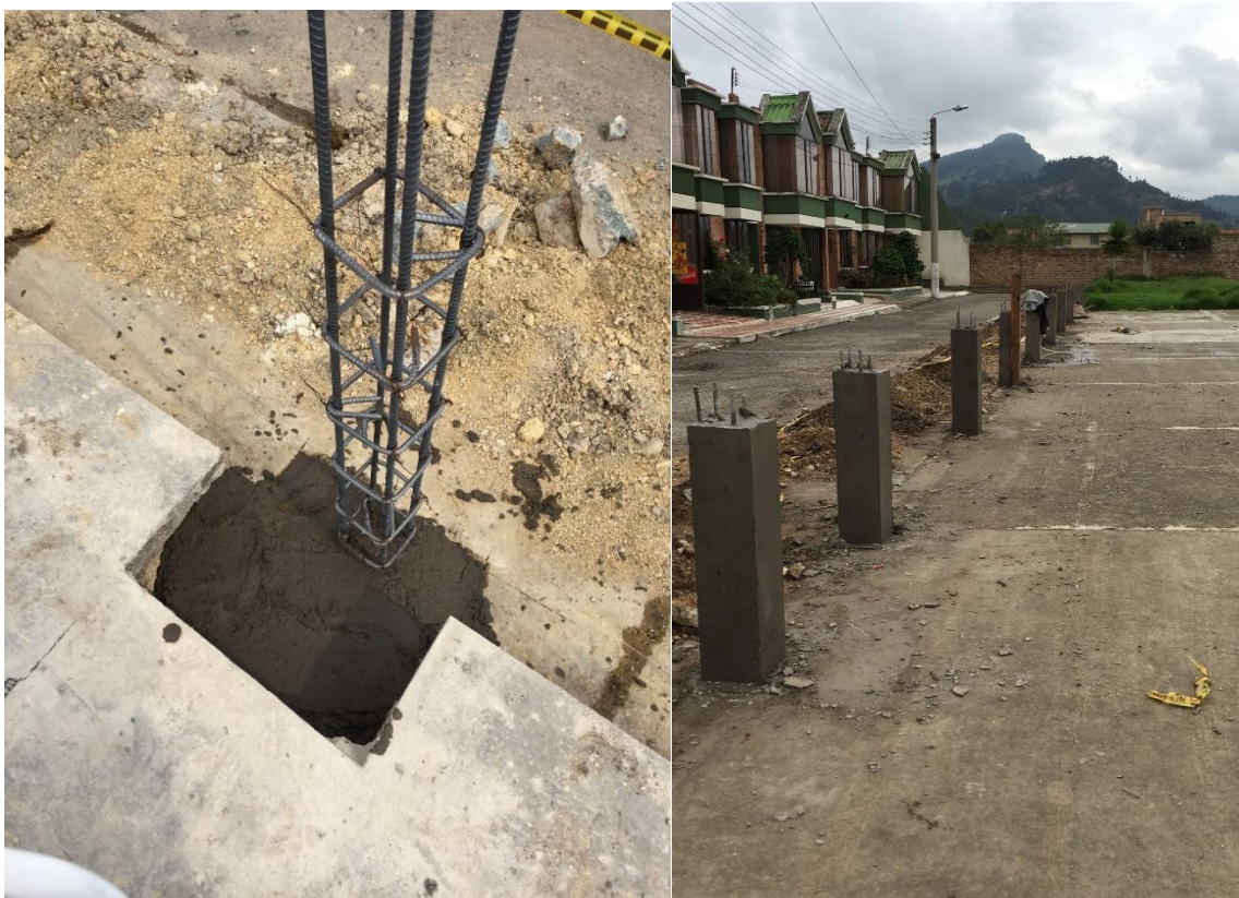
Imagen 10. Construcción de zapatas
