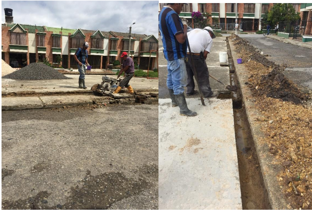
Imagen 9. Corte y excavación polideportivo el milagro.
