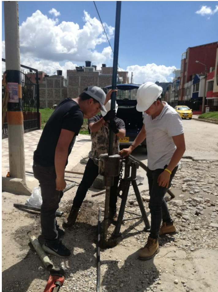
Imagen 26. Perforación manual
