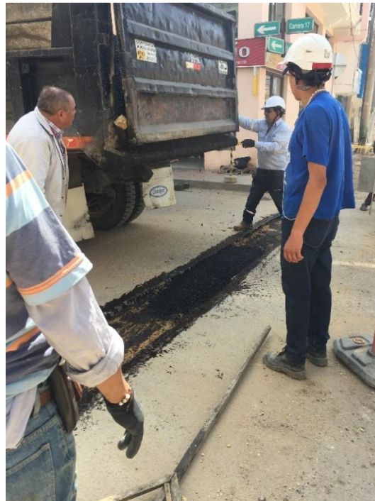
Imagen 23. Riego emulsión asfáltica
