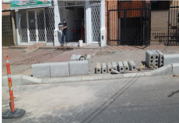
Figura 71. Instalación bordillo entrada a garaje.
