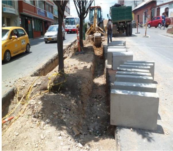
Figura 28. Construcción separador.
