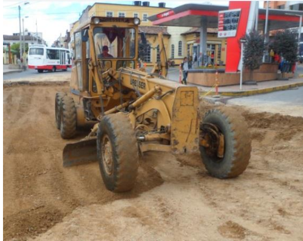
Figura 34. Tramo cra. 14 No. 21-08.
