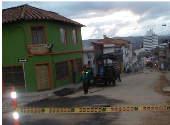
Figura 61. Riego de liga e imprimación.
