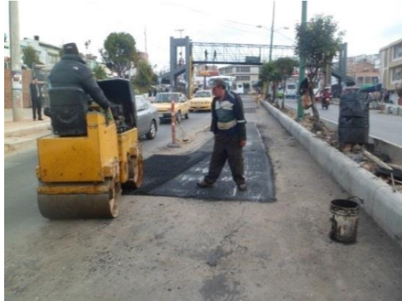
Figura 58. Compactación Vibrocompactador doble rodillo.
