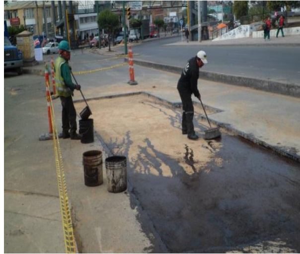
Figura 54. Detalle riego de liga.
