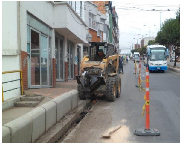
Figura 68. Demolición pavimento.
