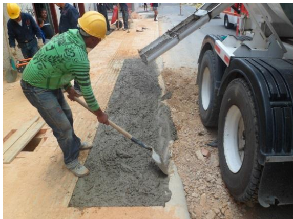
Figura 86. Detalle vaciado concreto.
