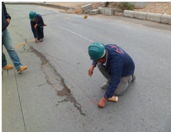
Figura 20. Demarcación fallas.
