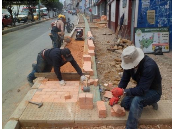
Figura 80. Instalación adoquín 1.
