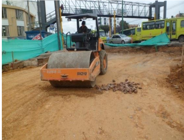
Figura 33. Compactación material de afirmado Miniglorigieta sector Hugolino.
