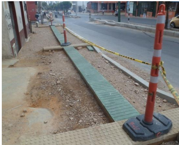
Figura 92. Detalle loseta táctil de alerta.
