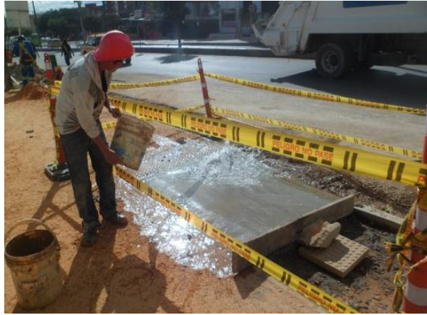
Figura 89. Curado concreto 2.
