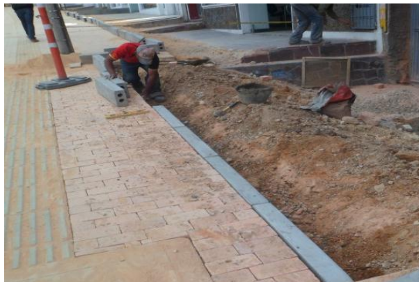
Figura 72. Confinamiento adoquín.
