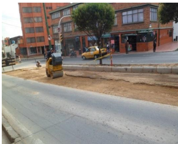
Figura 37. Vibrocompactador doble rodillo.
