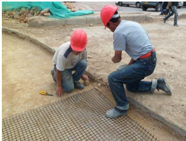
Figura 43. Instalación grapas.
