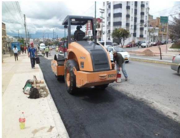
Figura 59. Compactación de parcheo.
