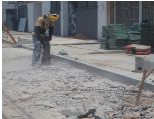
Figura 74. Demolición de pisos.
