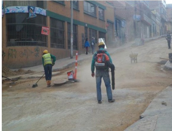
Figura 60. Detalle barrido y soplado.
