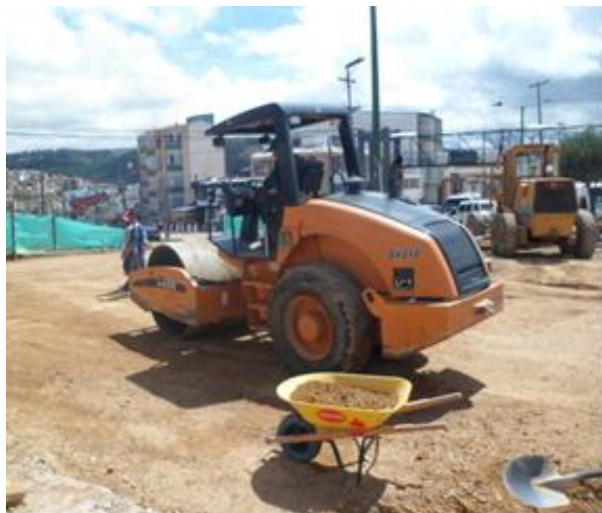
Figura 35. Tramo de compactación.
