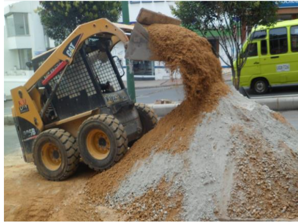
Figura 46. Extensión material.
