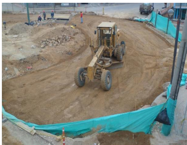
Figura 44. Nivelación base granular.
