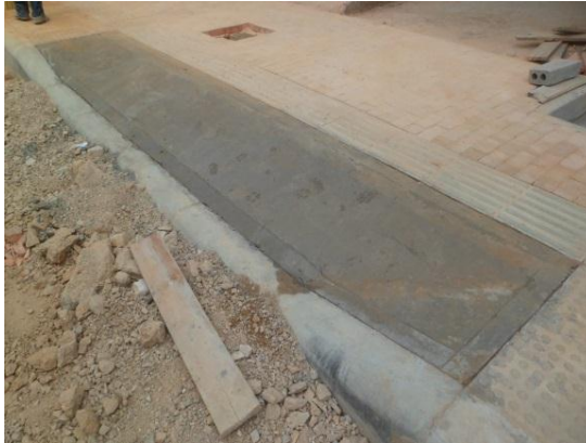
Figura 87. Detalle concreto final.
