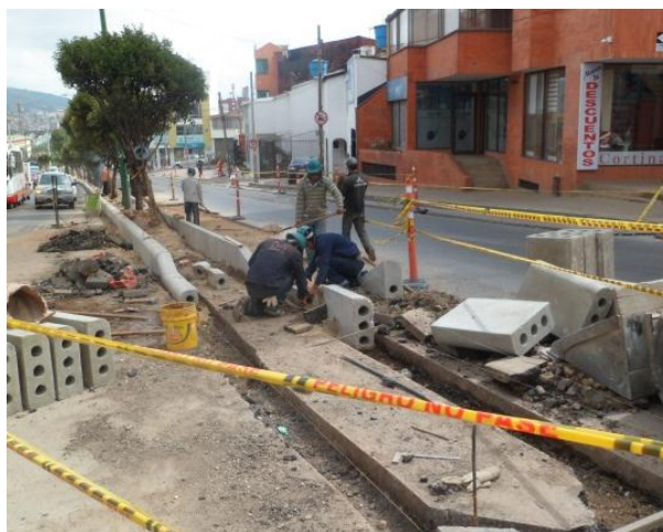
Figura 70. Instalación sardinel 2.
