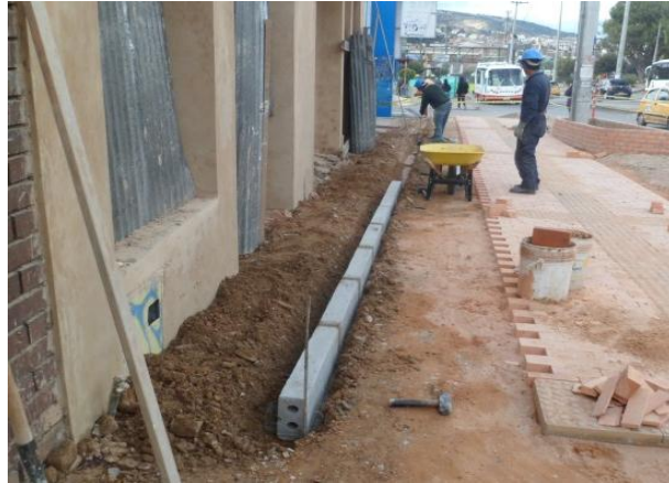
Figura 73. Confinamiento concreto.
