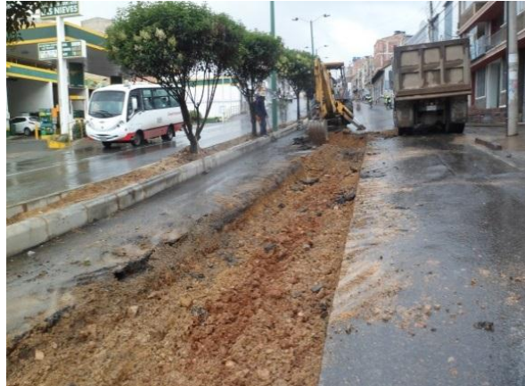
Figura 24. Detalle cajeo para parcheo.
