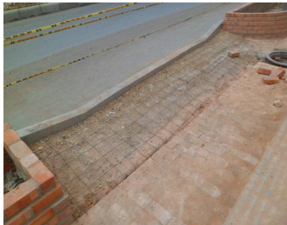
Figura 84. Malla electro soldada.
