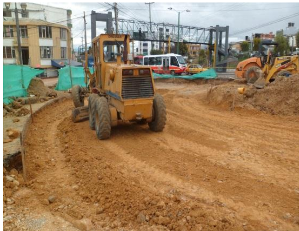
Figura 31. Extensión motoniveladora.
