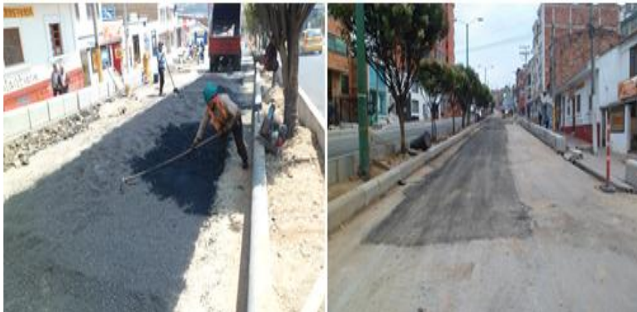
Figura 7. Detalle ejecución de parcheo.
