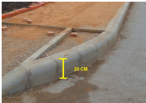
Figura 90. Detalle borde libre sardinel tipo A-10.
