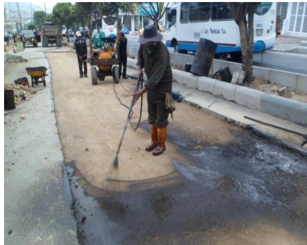
Figura 55. Detalle imprimación.
