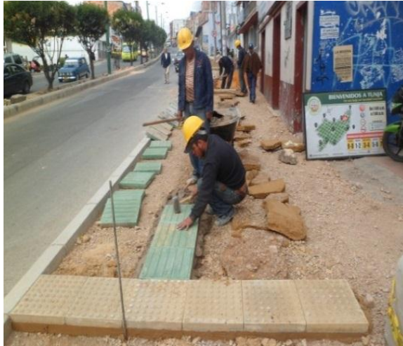
Figura 93. Detalle loseta táctil guía.
