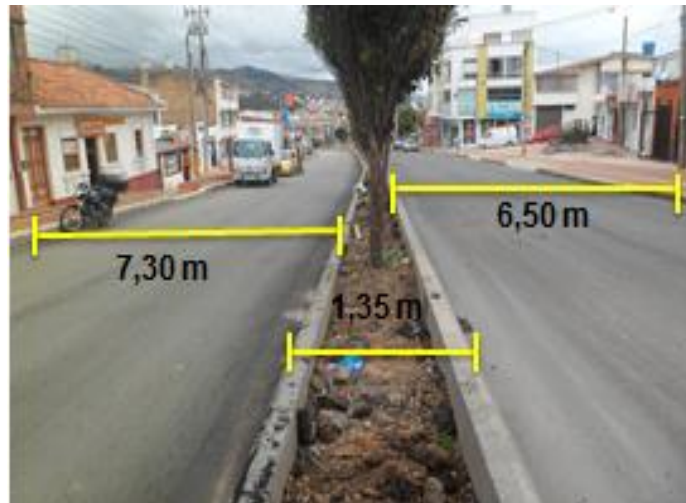
Figura 8. Detalle ampliación avenida Maldonado.
