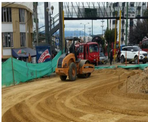
Figura 45. Detalle compactación.
