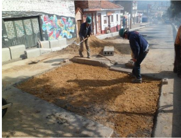
Figura 22. Detalle cajeo pavimento.
