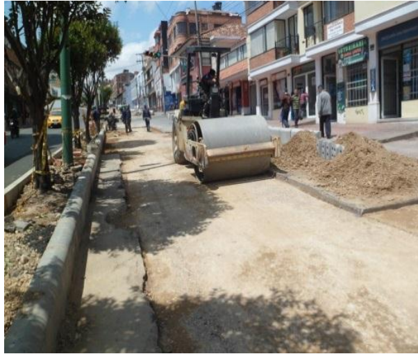
Figura 38. Vibrocompactador Ingersoll Rand.
