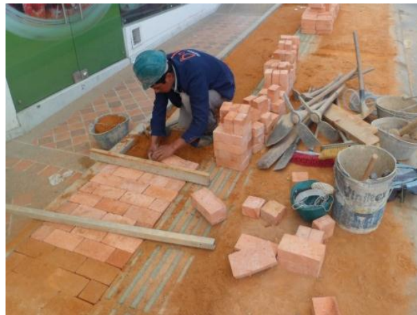
Figura 81. Instalación adoquín 2.
