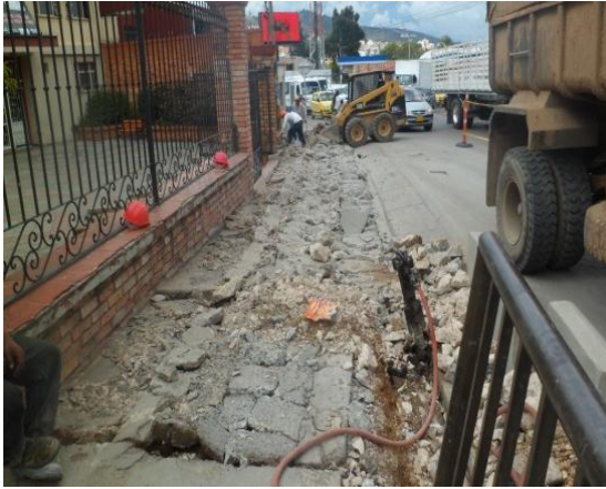
Figura 75. Acopio material sobrante.
