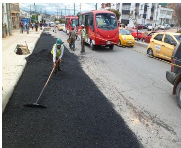
Figura 57. Extensión de material.
