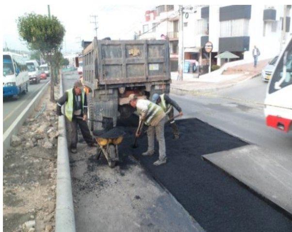
Figura 56. Disposición de material.
