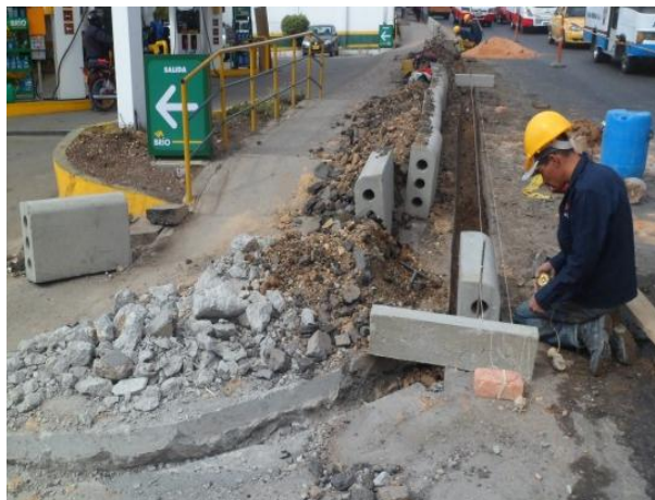
Figura 69. Instalación sardinel 1.
