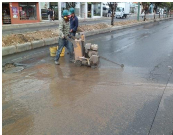
Figura 21. Corte de pavimento.
