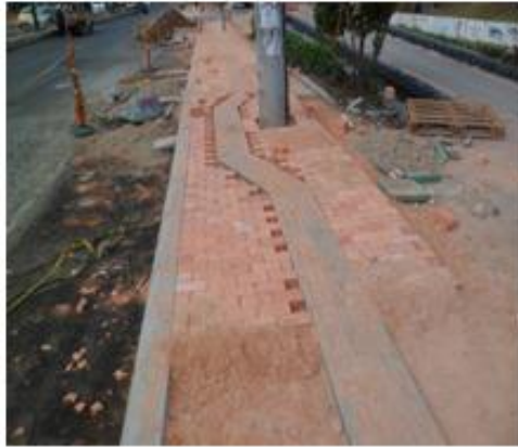
Figura 98. Actividad de instalación de adoquín final.
