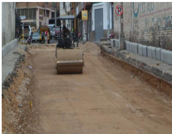
Figura 32. Compactación de material.
