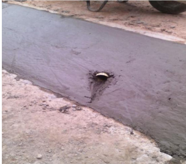
Figura 91. Detalle instalación tubería de desagüe.
