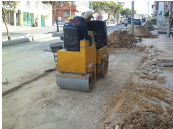
Figura 47. Tramo en compactación.
