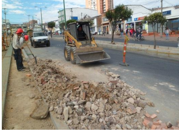
Figura 29. Detalle acopio material.
