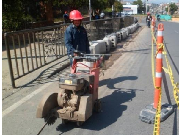
Figura 65. Cortadora de pavimento.
