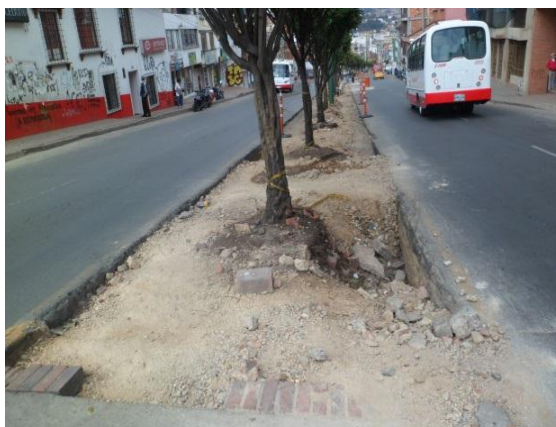
Figura 17. Separador Avenida Maldonado.
