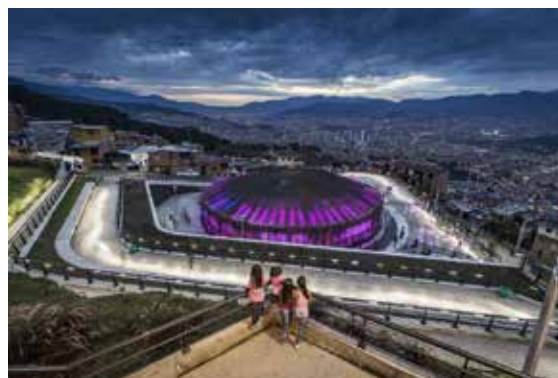
Figura 10. UVA Los Sueños, Tanque Versalles. Cortesía de EPM en: La historia de cómo Medellín convirtió sus tanques de agua en verdaderos parques públicos, 2016
