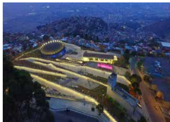
Figura 8. UVA Nuevo Amanecer. Cortesía de EPM en: La historia de cómo Medellín convirtió sus tanques de agua en verdaderos parques públicos, 2016
