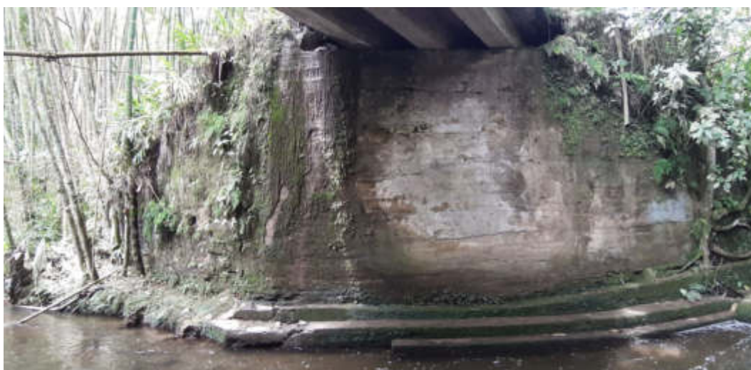
Figura 8. Estribo costado sur.
