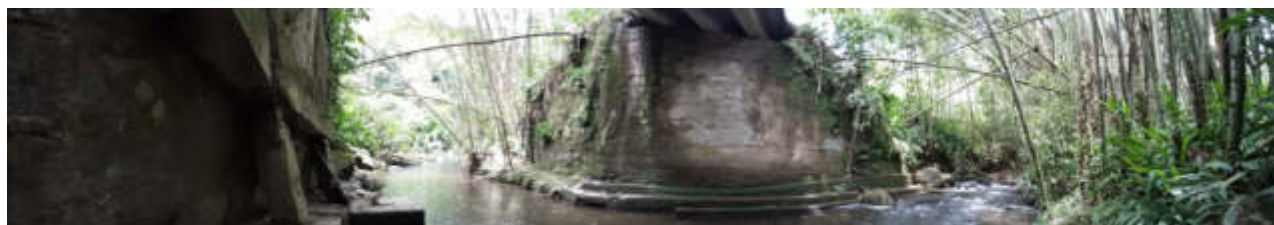
Figura 15. Panorámica de la implantación del puente
