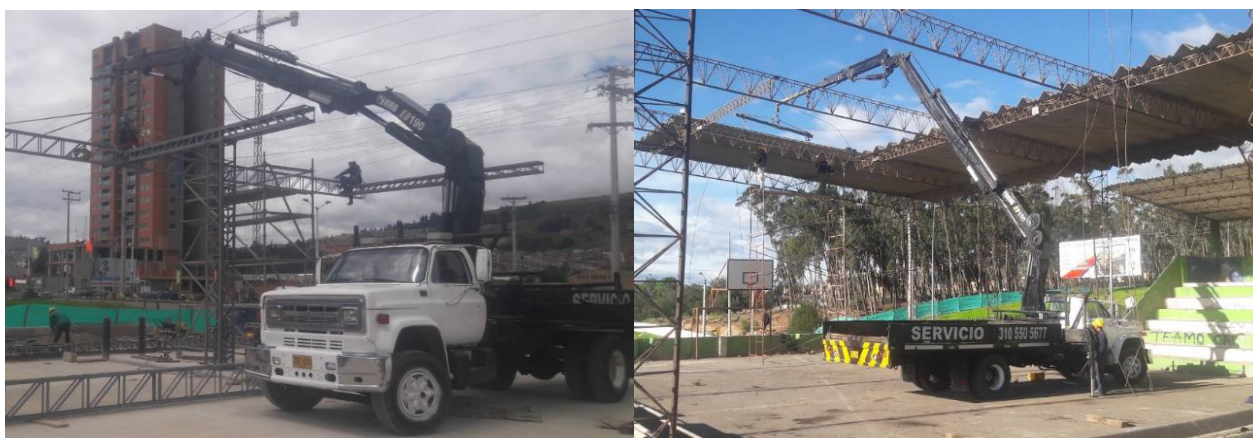
Figura 1. Servicio de Izaje de grúa por CODIMELCO S.A.S
