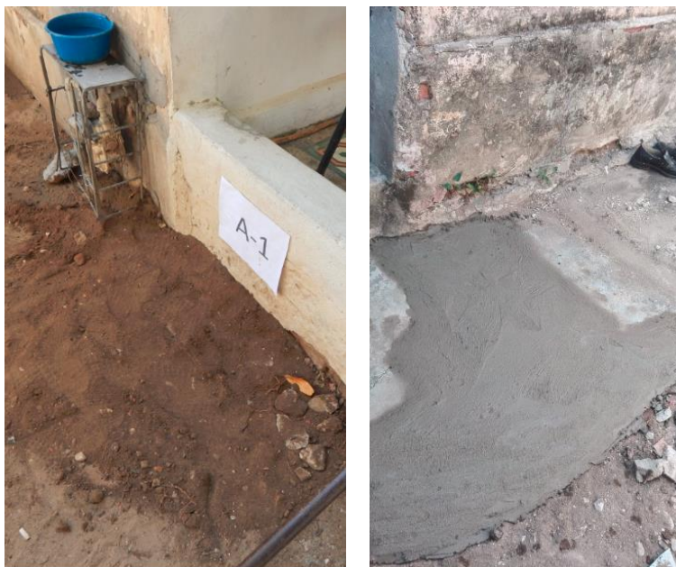
Fotografías 4 y 5: posterior a la ejecución de los apiques 1 y 2 se procedió a cubrir las exploraciones y realizar plantilla en mortero para el caso del apique N° 2 realizado a nivel de patio.
