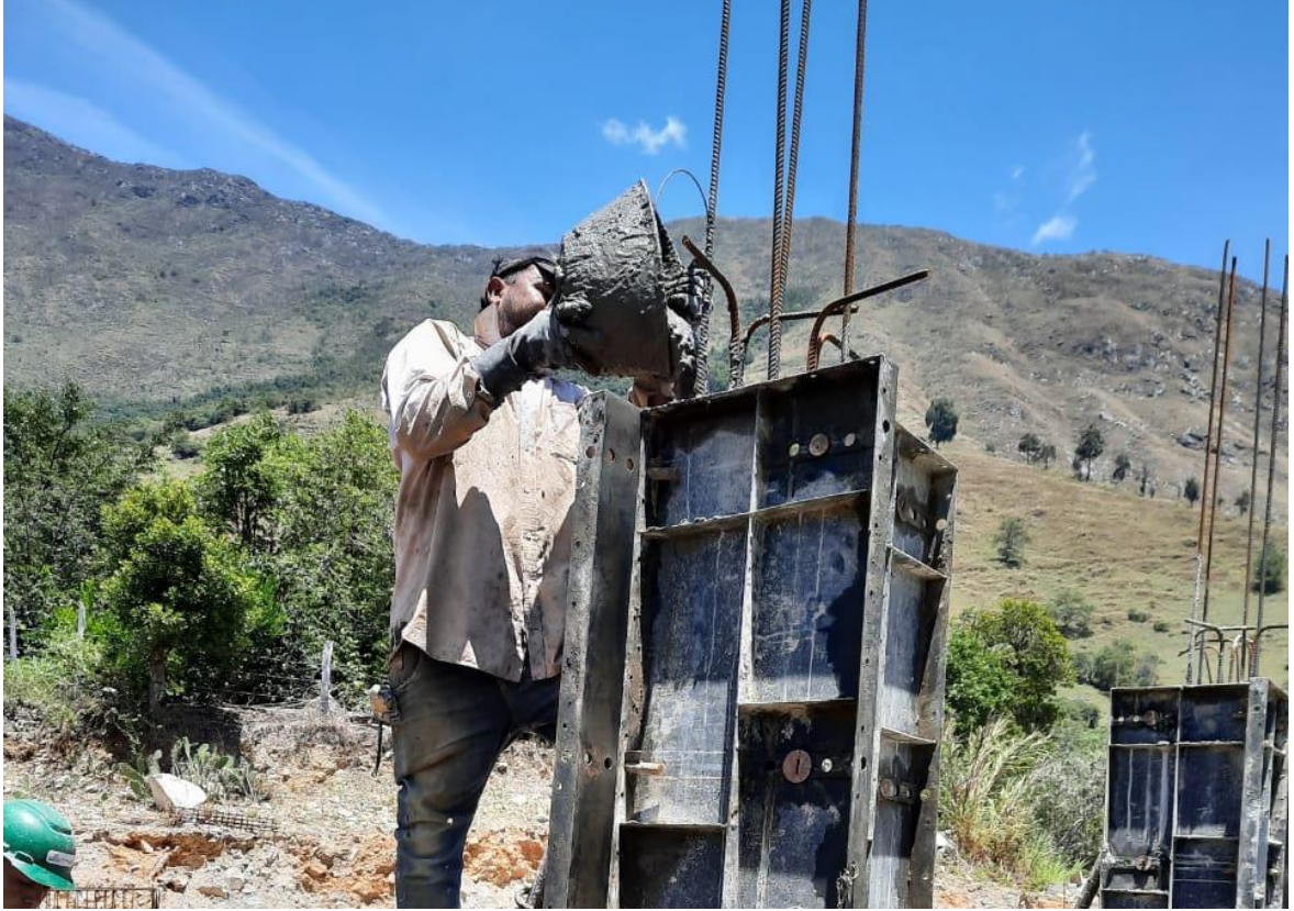
Imagen 3. Vaciado in situ de concreto (columnas).
