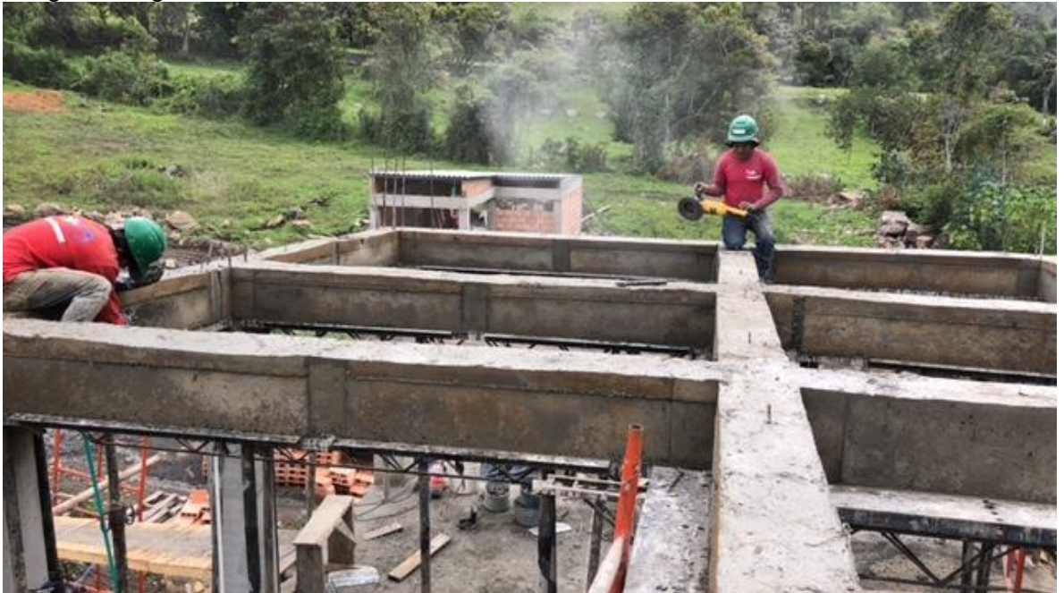
Imagen 4. Vigas en concreto.
