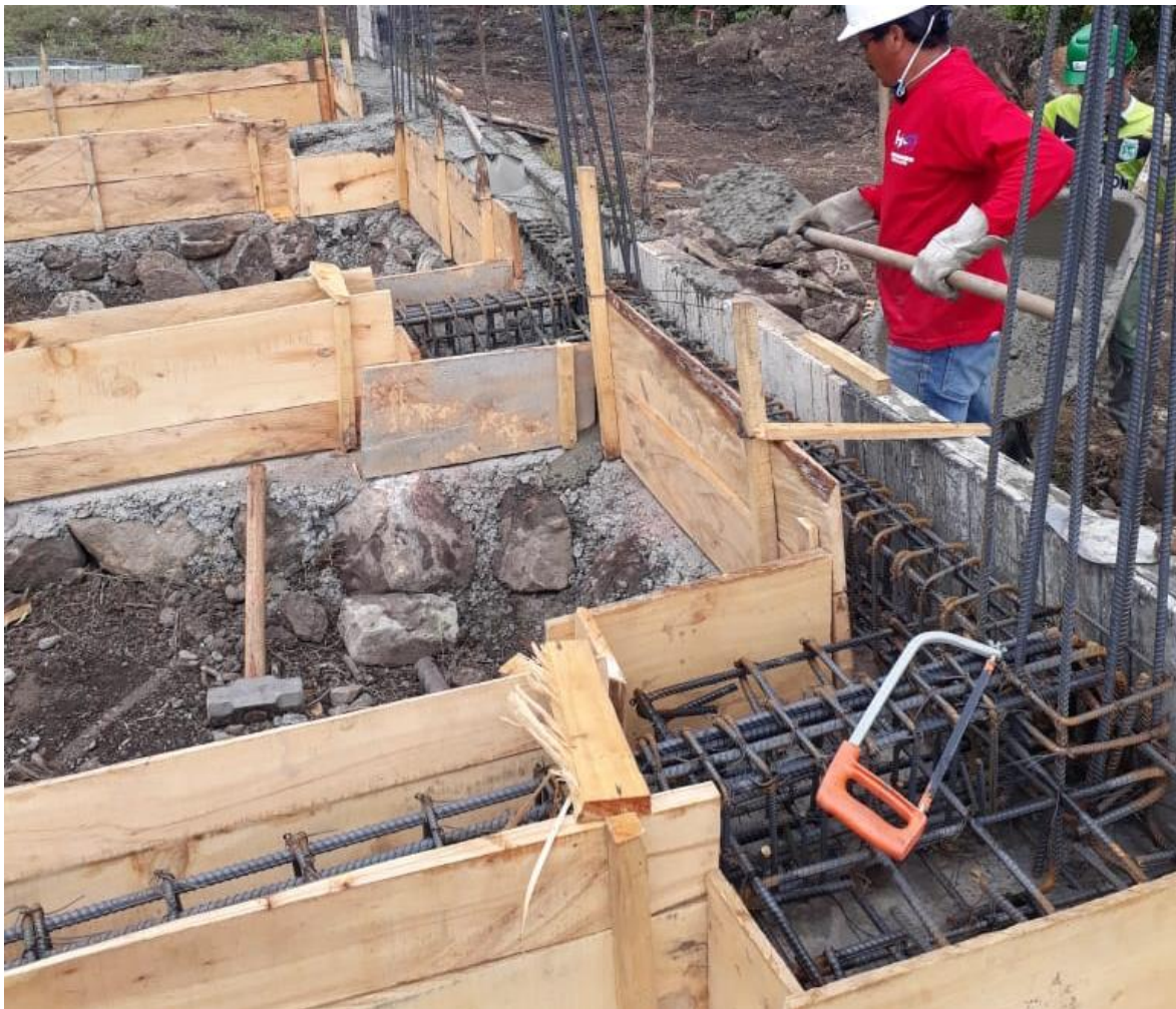
Imagen 6. Vaciado de concreto para cimentación de vivienda a construir.
