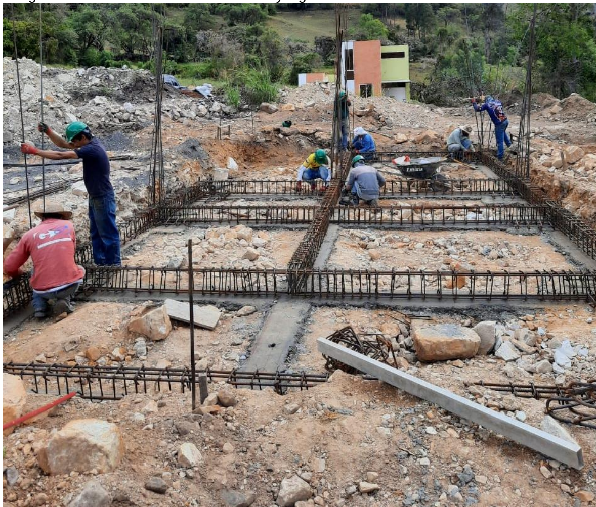
Imagen 5. Amarre de acero de columnas y vigas.
