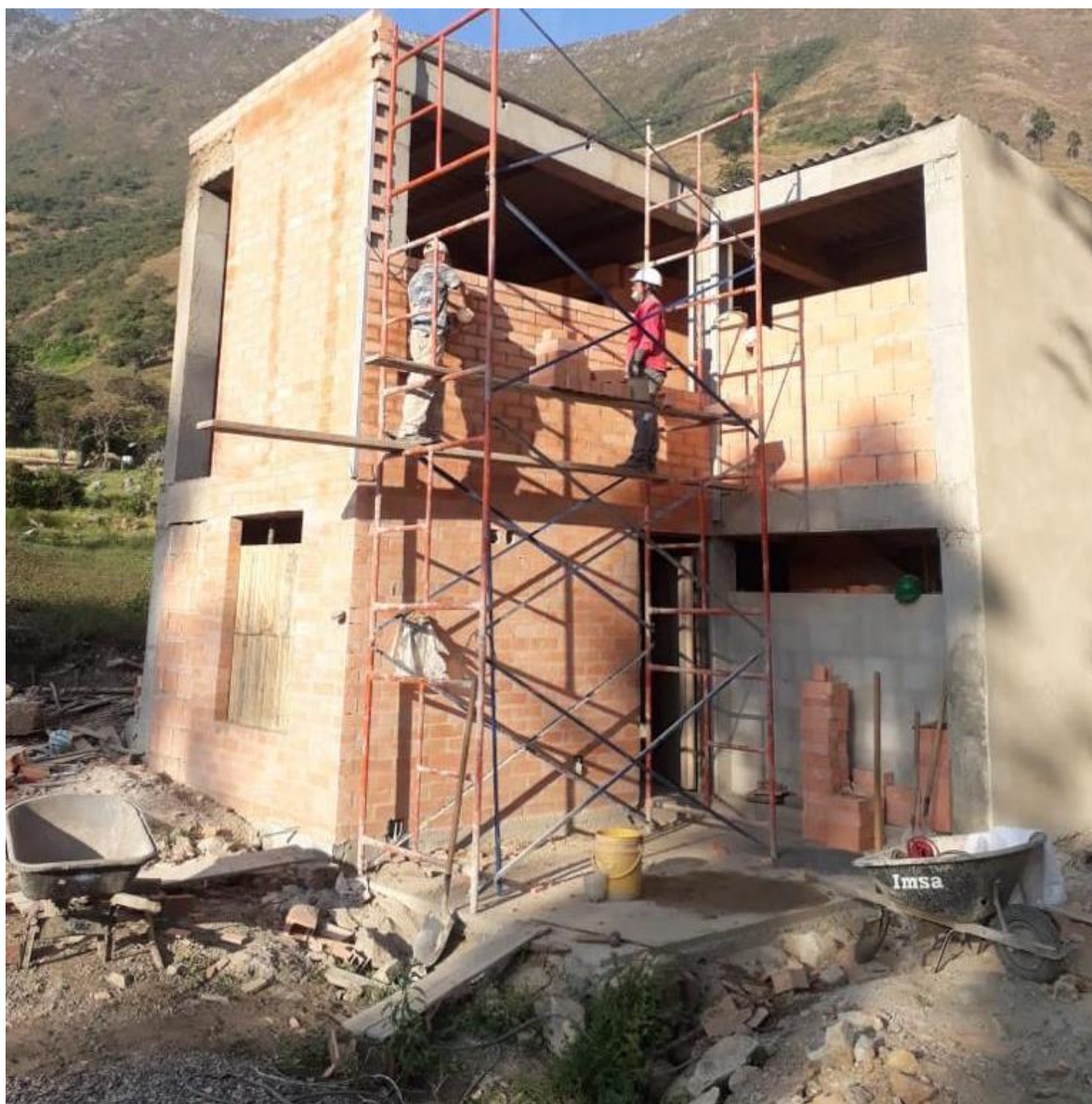
Imagen 11. Construcción de muro de fachada en vivienda tipo 2.
