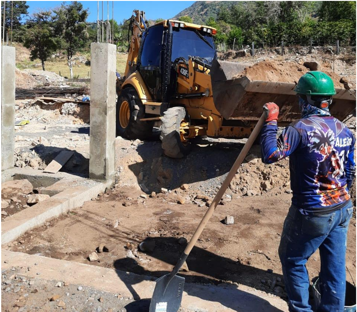
Imagen 9. Uso de maquinaria pesada (Retroexcavadora).
