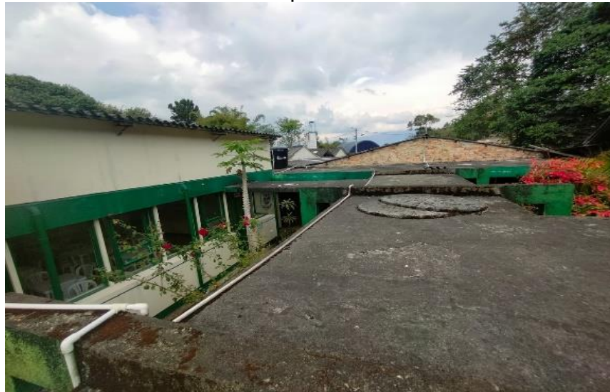
Figura 9. Loza en concreto sobre el pasillo de acceso a los salones de clase.
