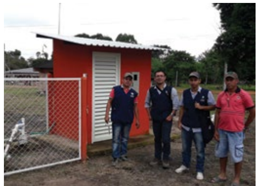
Visita diagnóstica acueducto veredal de San Lucas, El Retorno
