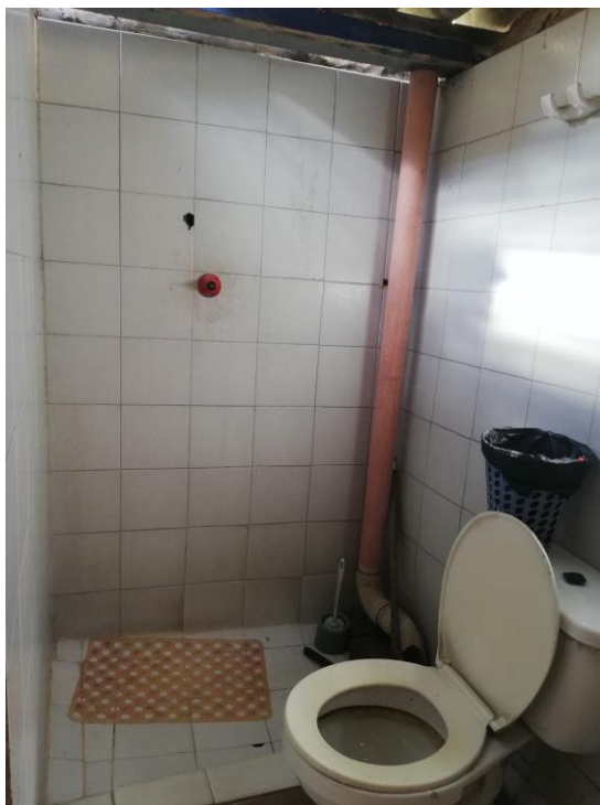
Figura 19. Estado actual baño y cocina.
