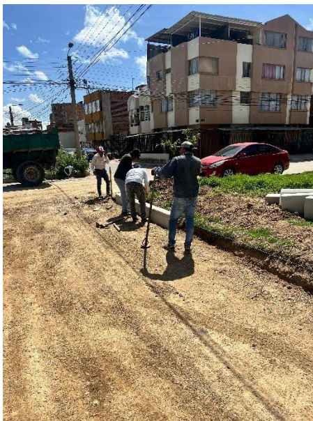
Ilustración 12. Instalación de sardineles
