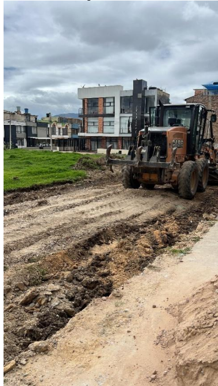
Ilustración 6. Cajeo con motoniveladora
