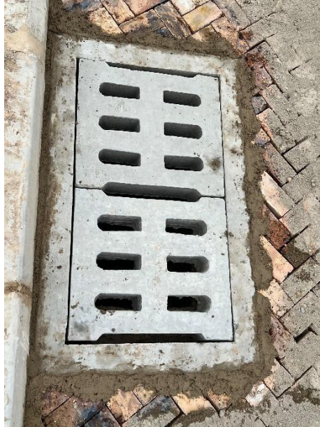
Ilustración 14. Instalación de sumideros
