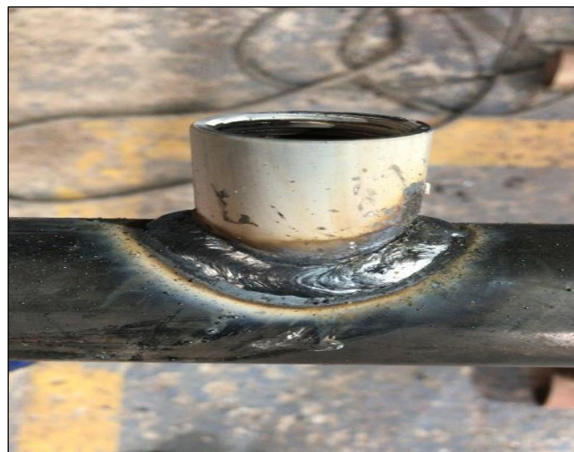
Imagen 4. Accesorio tipo outlet unido a tubería por medio de soldadura MIG
