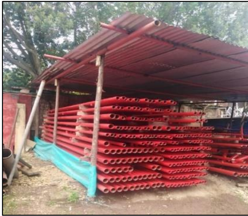
Imagen 6. Red contraincendios prefabricada
