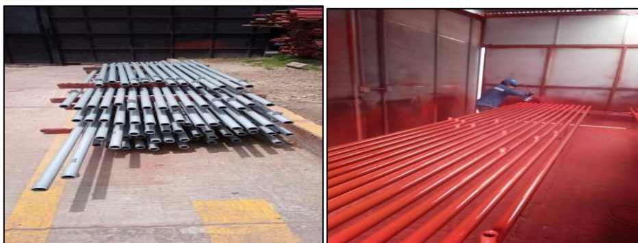
Imagen 7. Proceso prefabricado redes contraincendios
