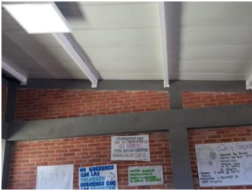
Fotografía 3: Vista de aula en uso
