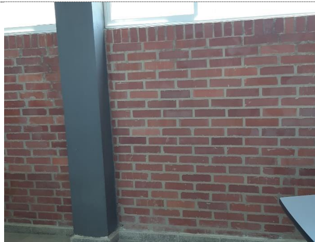
Fotografía 2: Vista muro de una de las aulas de clase
