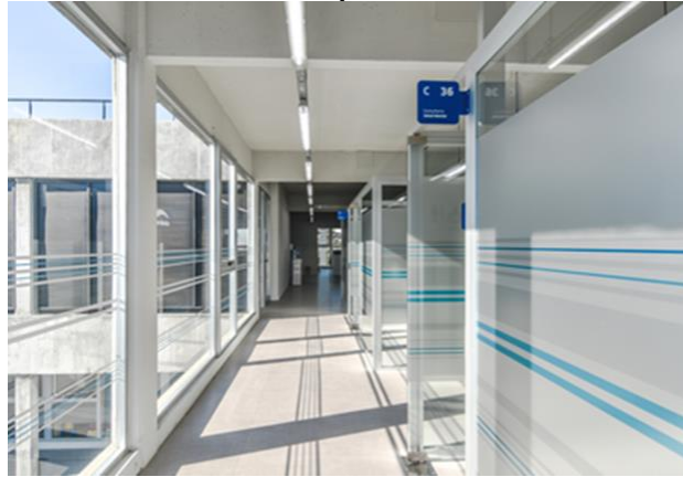
Figura 36. Pasillo entre los consultorios del tercer piso
