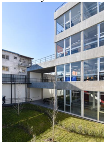
Figura 35. Vista desde patio interior hacia los diferentes niveles del edificio
