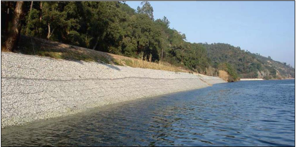
Ilustración 11-3 Gavión. Fuente: Bianchini Ingeniero – Gaviones
