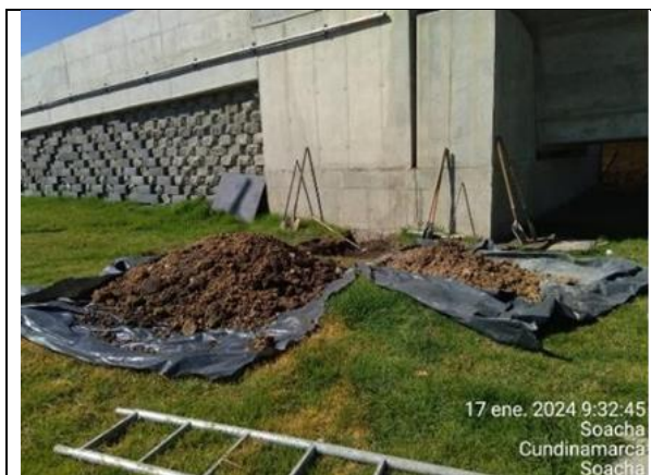
Imagen 26. acopio de RCD de excavación sobre zona verde.
