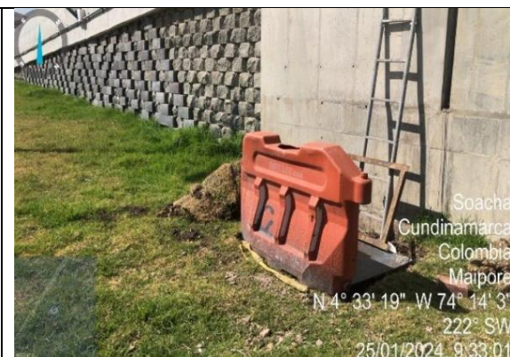
Imagen 25. Registro fotográfico capa vegetal retirada para ejecutar actividades de excavación
