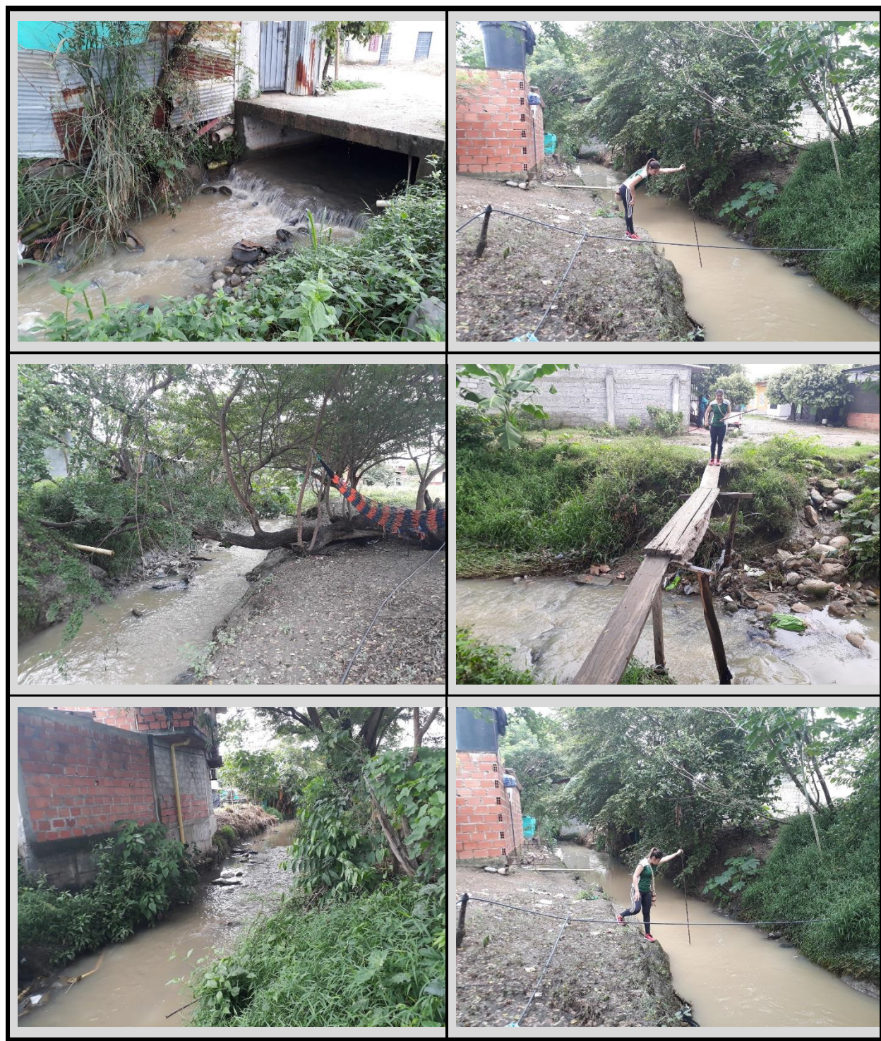
Figura 40. Levantamiento fotográfico caño mono zona de intervención. Tomado: 06-17-2016.
