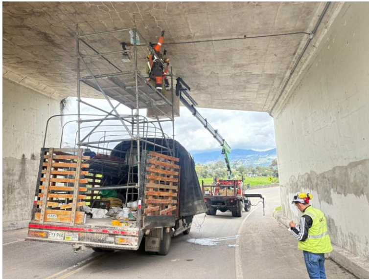
Figura 23 Reparación Box-Culvert Intersección Juan Rey.
