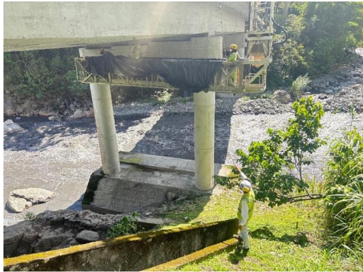
Figura 20 Reparación Puente La Balsa
