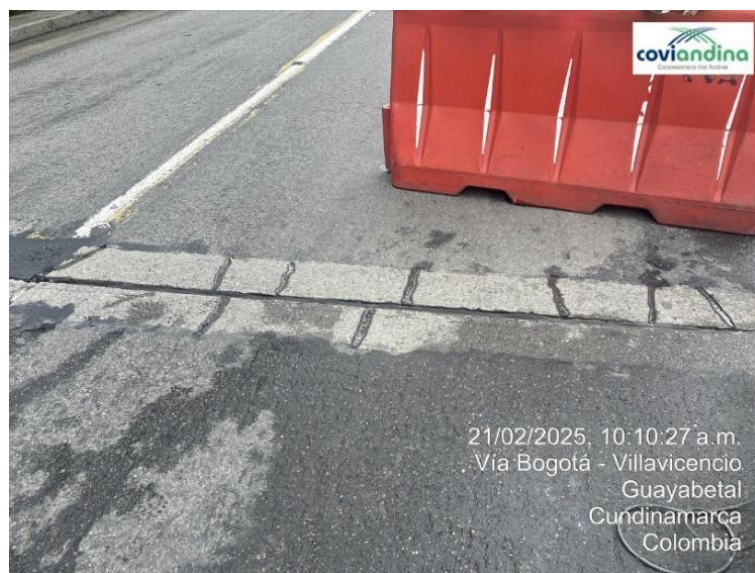
Figura 10 Reparación puente Aserrio
