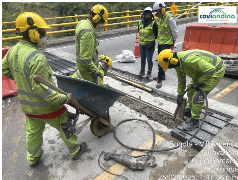
Figura 11 Reparación Quebrada Blanca.
