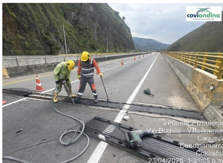
Figura 21 Reparación Puente 2 Izquierdo.
