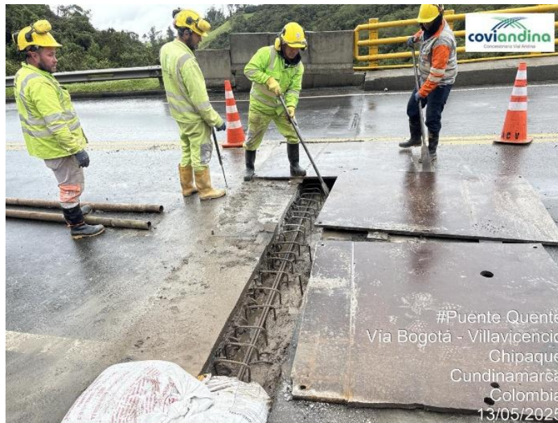
Figura 22 Reparación Puente Quente.
