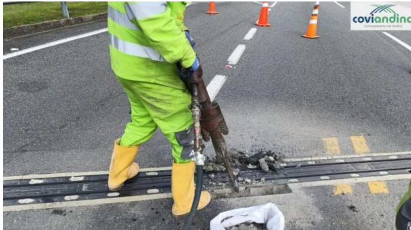
Figura 3 Reparación Puente “Reforma vía Nueva”
