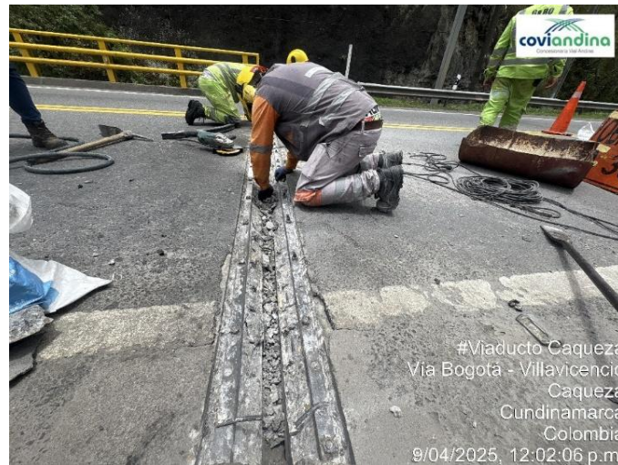
Figura 17 Reparaciones Viaducto Cáqueza.
