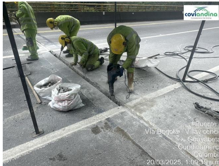
Figura 14 Reparación Puente 5 Sector 3.
