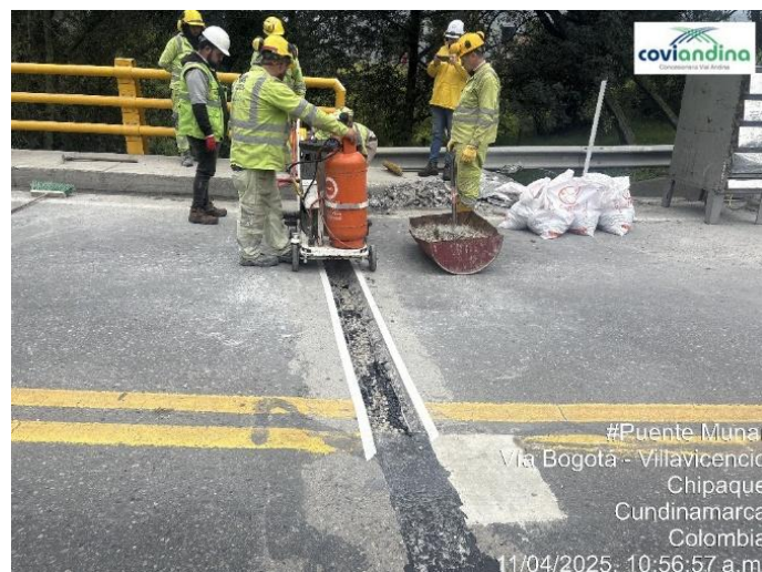
Figura 18 Reparación Puente Munar.
