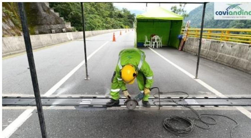
Figura 2 Reparación Puente 9A
