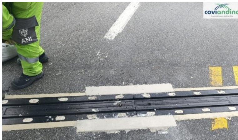
Figura 4 Reparación puente “Reforma vía existente”
