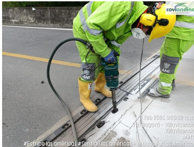
Figura 5 Reparación puente Américas
