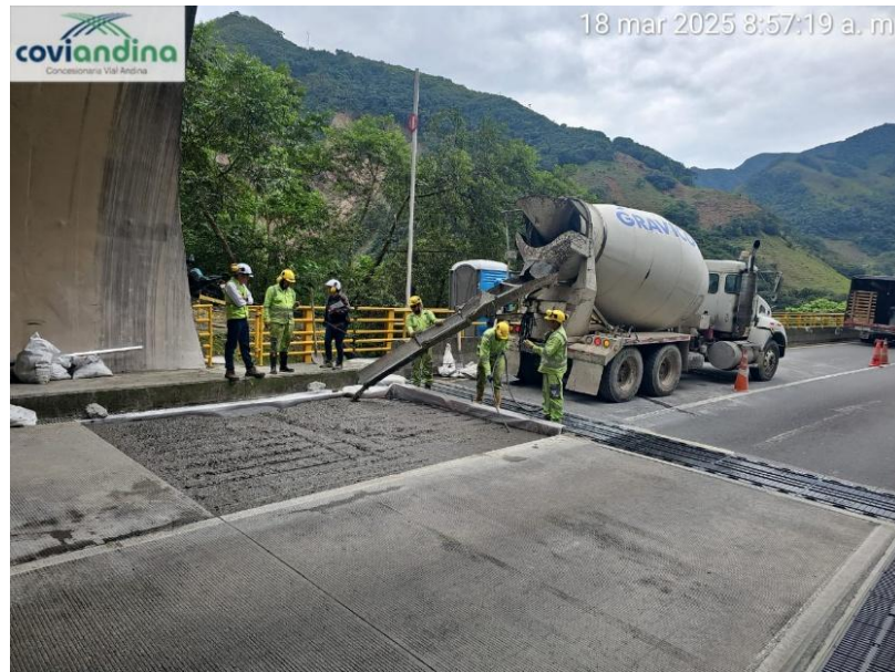
Figura 13 Reparación placa Túnel 3.
