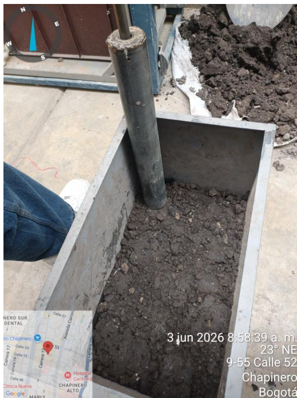
Figura 4. Proceso de compactación.
