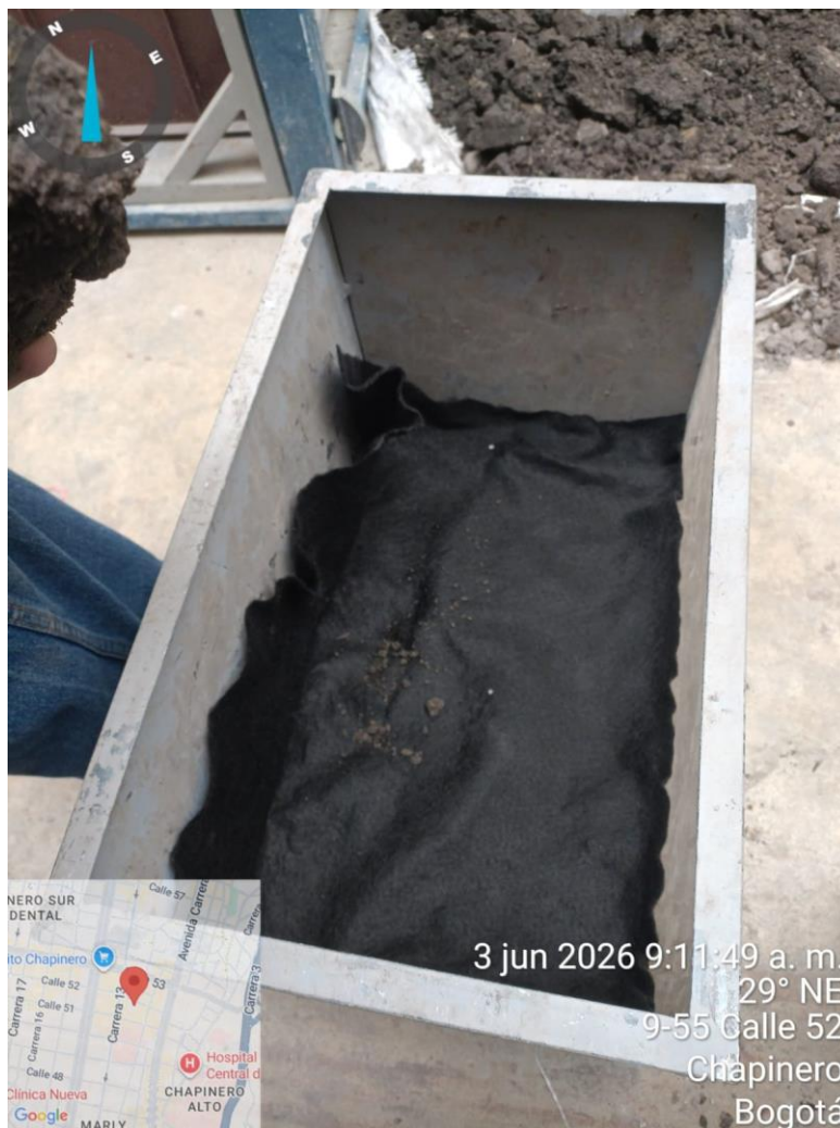
Figura 5. Aplicación geotextil NT 1600.
