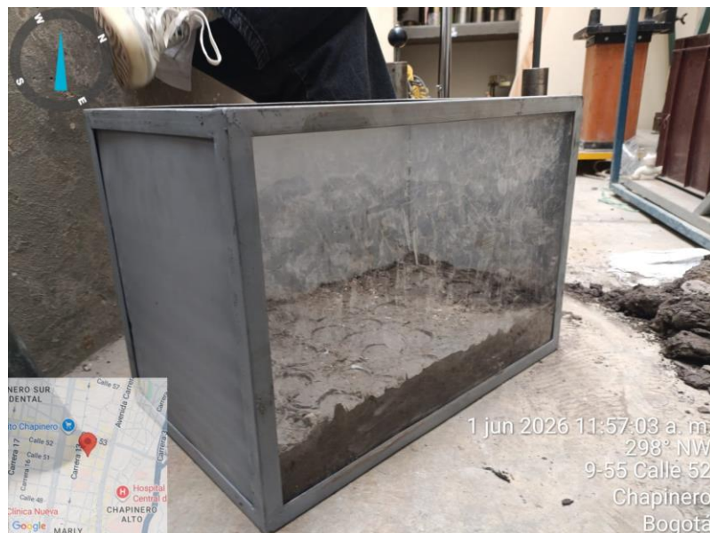
Figura 2. Proceso de compactación.
