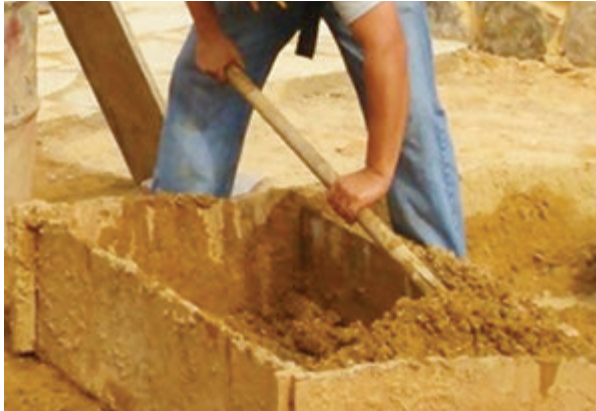
► Imágenes de autoría propia donde se evidencia el proceso de fabricación de la arcilla para el adobe.
