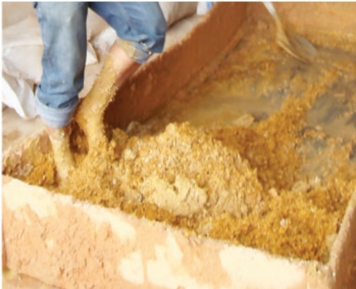
Imágenes de autoría propia donde se evidencia el proceso de fabricación de la arcilla para el adobe pisado en bateas.
