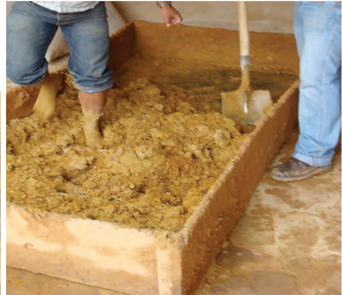
Imágenes de autoría propia donde se evidencia el proceso de fabricación de la arcilla para el adobe pisado en bateas.
