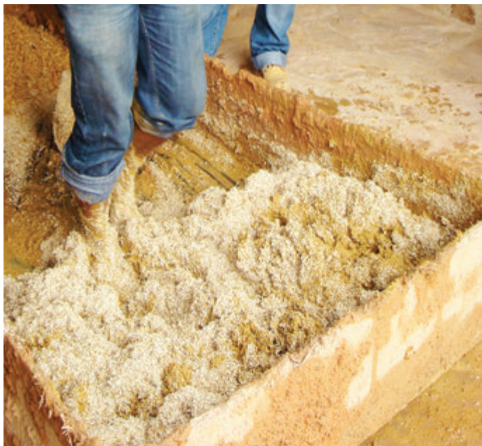
Imágenes de autoría propia donde se evidencia el proceso de fabricación de la arcilla para el adobe pisado en bateas.
