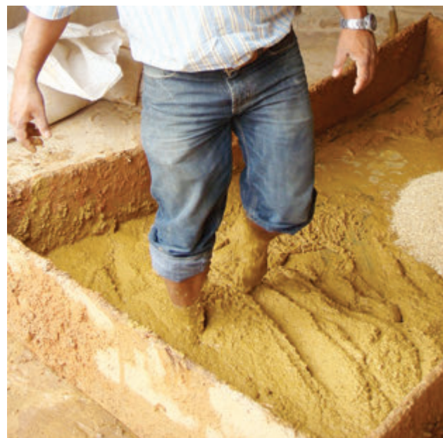
Imágenes de autoría propia donde se evidencia el proceso de fabricación de la arcilla para el adobe pisado en bateas.
