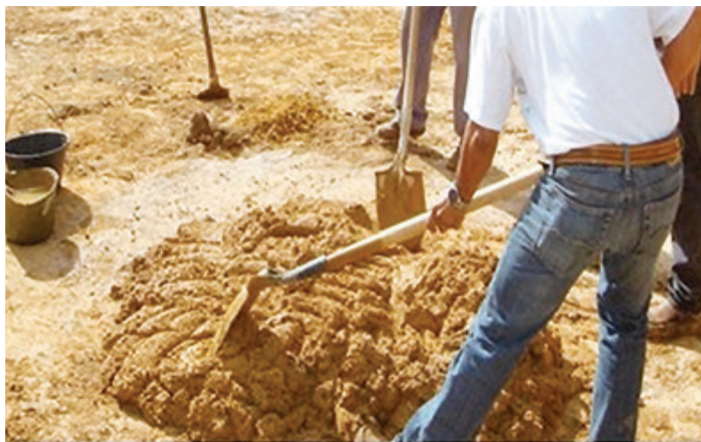
Imágenes de autoría propia donde se evidencia el proceso de fabricación de la arcilla para el adobe.
