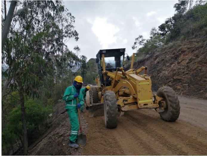
Ilustración 24. Proceso de seriado de base en el Pr 0+450
