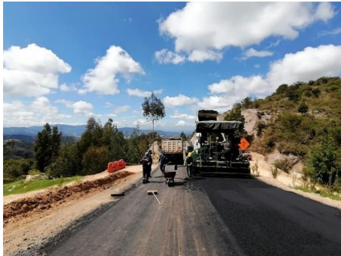
Ilustración 28. Extendido de mezcla asfáltica con ayuda de la finisher
