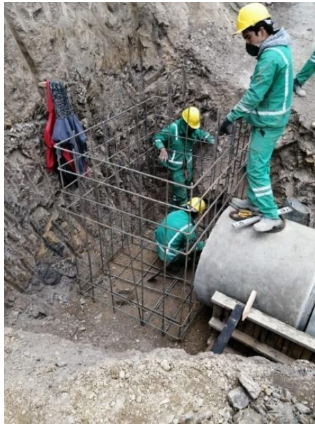
Ilustración 8. Armado de acero para encole del PR 0+937
