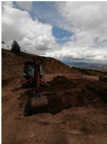
Ilustración 4. Excavación para el descole de la alcantarilla PR0+937
