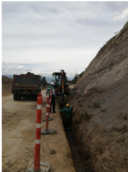
Ilustración 12. Excavación para filtro PR 0+150.
