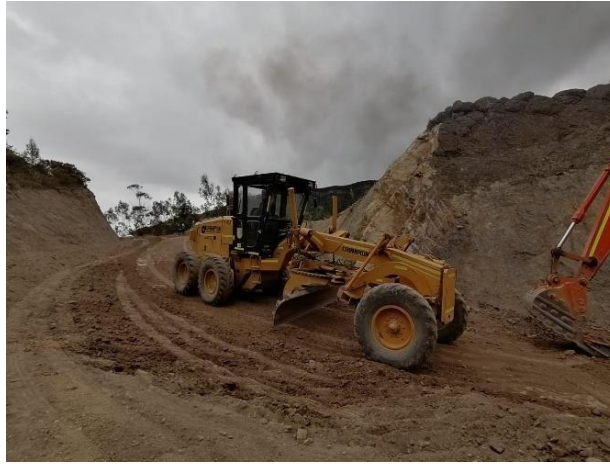
Ilustración 19. Proceso de seriado sub rasante en el PR0+500
