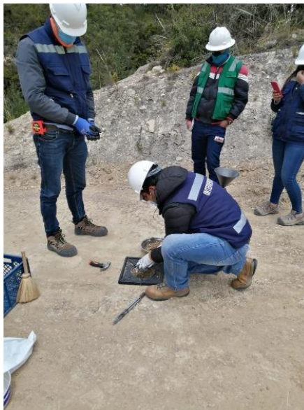
Ilustración 23. Toma de densidades (método del cono) interventoría
