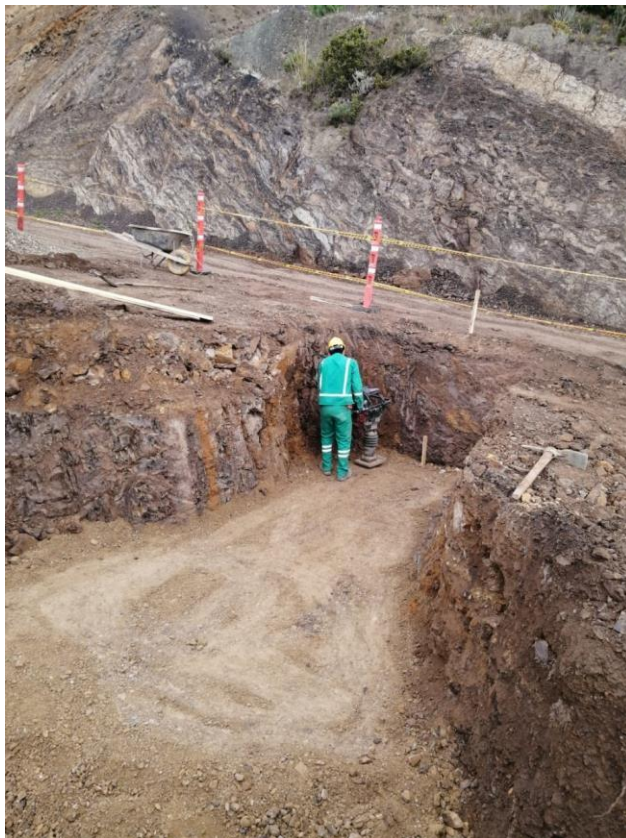
Ilustración 5. Compactación material de afirmado para descole PR0+937
