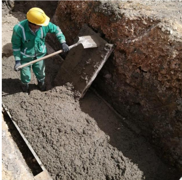
Ilustración 6. Fundido solado para descole de la alcantarilla PR0+420
