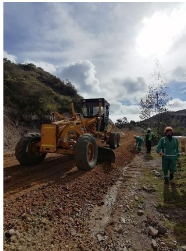
Ilustración 21. Proceso de seriado sub base en el PR 0+100.
