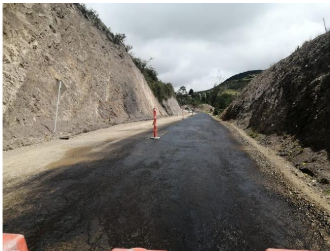
Ilustración 27. Aspersión de ligante asfáltico sobre eje izquierdo
