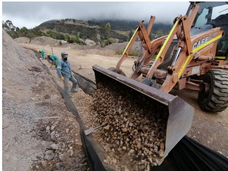
Ilustración 13. Relleno de filtro con piedra filtro PR0+200
