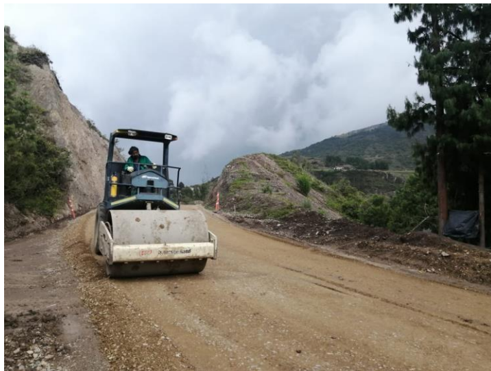
Ilustración 25. Proceso de compactación material base en el PR0+300
