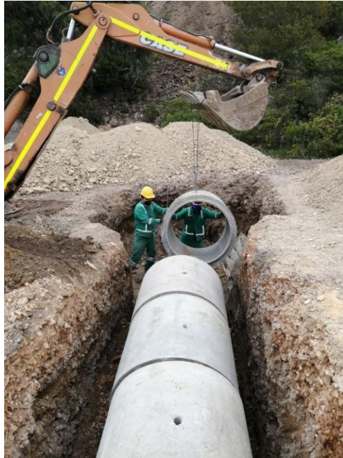
Ilustración 7. Ubicación tubería 36" en el encole del PR1+050
