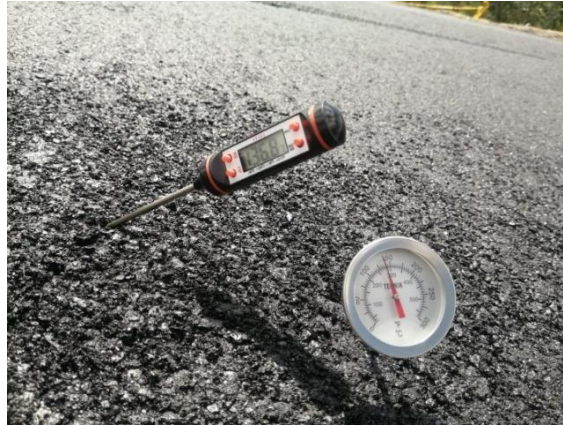
Ilustración 29. Toma de temperatura de la mezcla asfáltica
