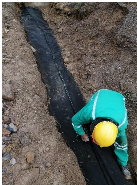
Ilustración 15. Cosido de material Geotextil en el PR 0+580.
