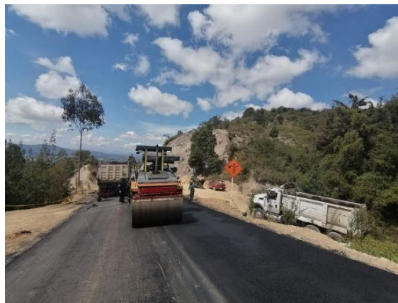
Ilustración 30. Compactación de mezcla con el equipo de doble rodillo
