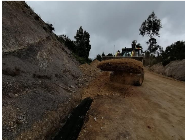
Ilustración 14. Cubrimiento con recebo fino sobre filtro vial PR 0+150.
