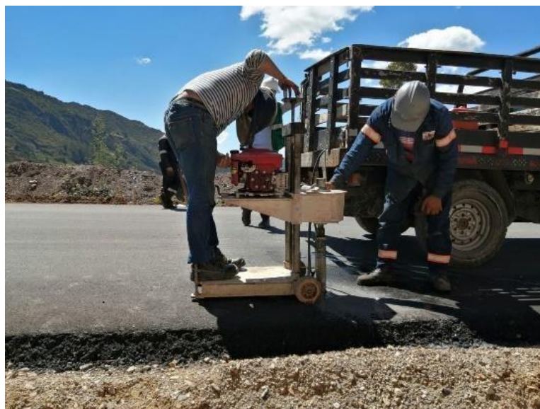
Ilustración 31. Extracción de núcleos
