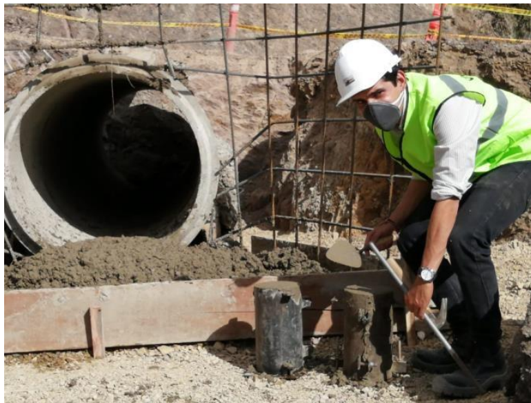
Ilustración 34. Elaboración de cilindros con material de solado
