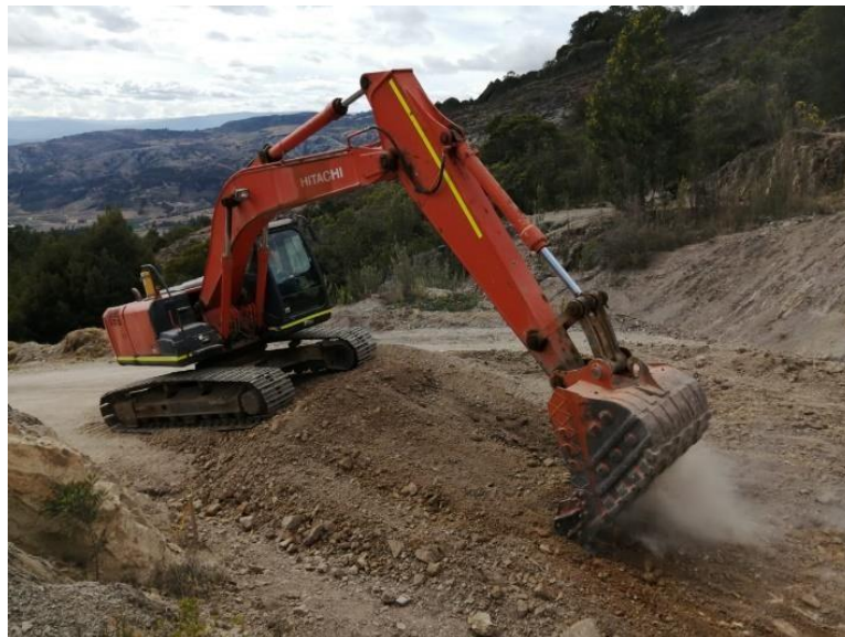
Ilustración 18. Proceso de cajeo en el PR0+490.
