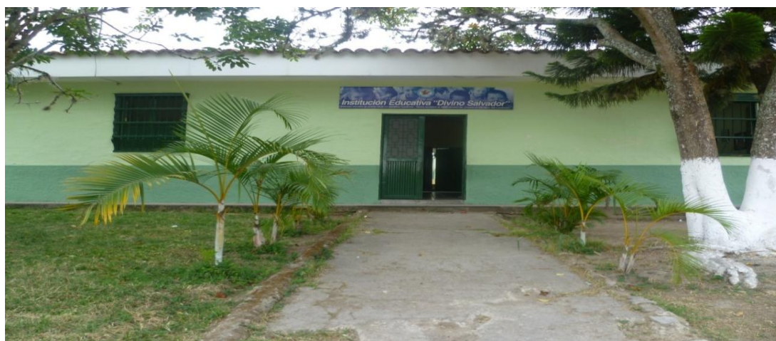
Figura 1. Entrada principal de la sede central I.E. Divino Salvador
