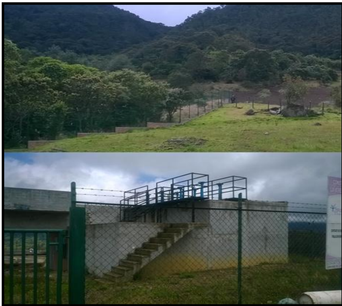
Figura 2-1: Fotografía de la visita de reconocimiento de la zona de estudio.
