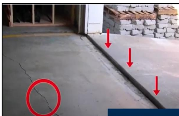
Figura 62. Ejemplos de inyección en losas
