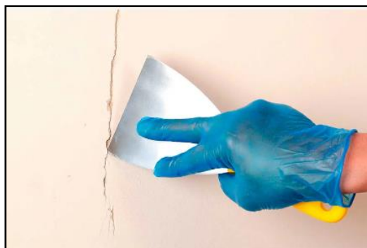
Figura 69. Limpieza de fisura
