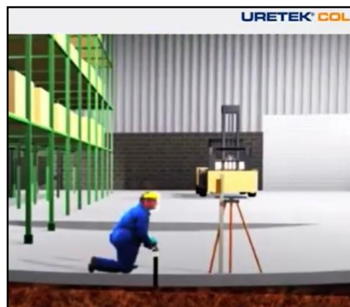
Figura 59. Perforación para inyección
