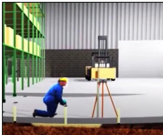
Figura 60. Penetración para inyección
