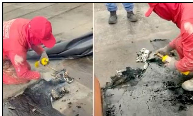
Figura 74. Retiro de manto
