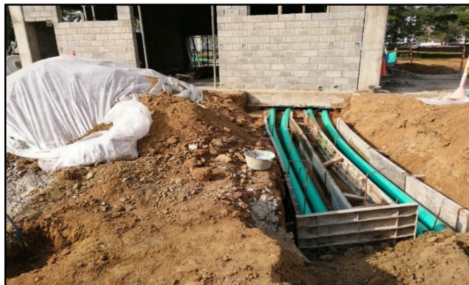
Figura 51. Instalación de tuberías durante el proceso constructivo
