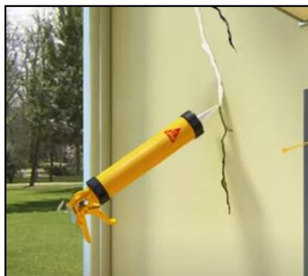
Figura 71. Relleno de fisura
