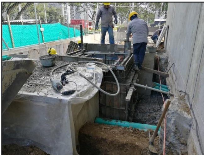
Figura 53. Excavaciones adicionales por instalación de tuberías durante el proceso constructivo
