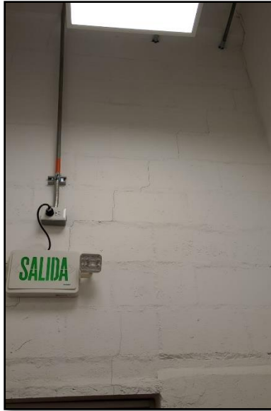
Figura 50. Fisura diagonal en muro de fachada
