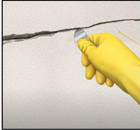
Figura 70. Corte de acabado en fisuras
