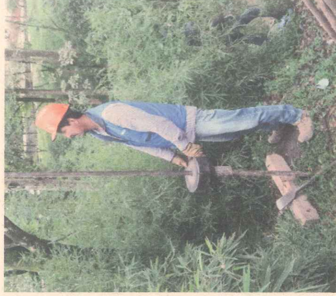
REALIZACION DEL SONDEO 1
