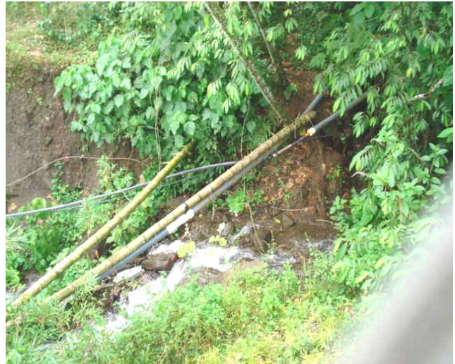
FIG No 7: Línea de aducción paso elevado aducción Mateguadua y tramo elevado aducción la peña
