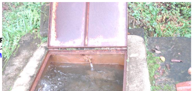
FIG No 10: Tanque de dilución cloro y punto de aplicación de la solución desinfectante
