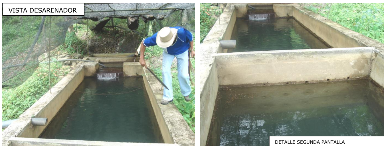
FIG No 12: Detalles Desarenados Los Lirios
