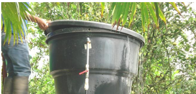
FIG No 10: Tanque de dilución cloro y punto de aplicación de la solución desinfectante
