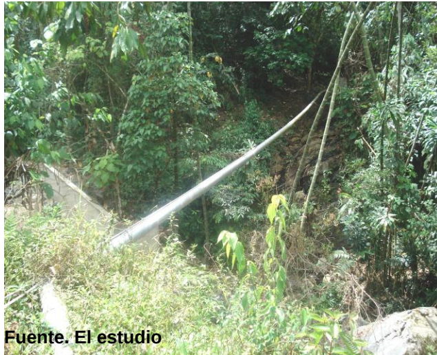
FIG No 7: Línea de aducción paso elevado aducción Mateguadua y tramo elevado aducción la peña
