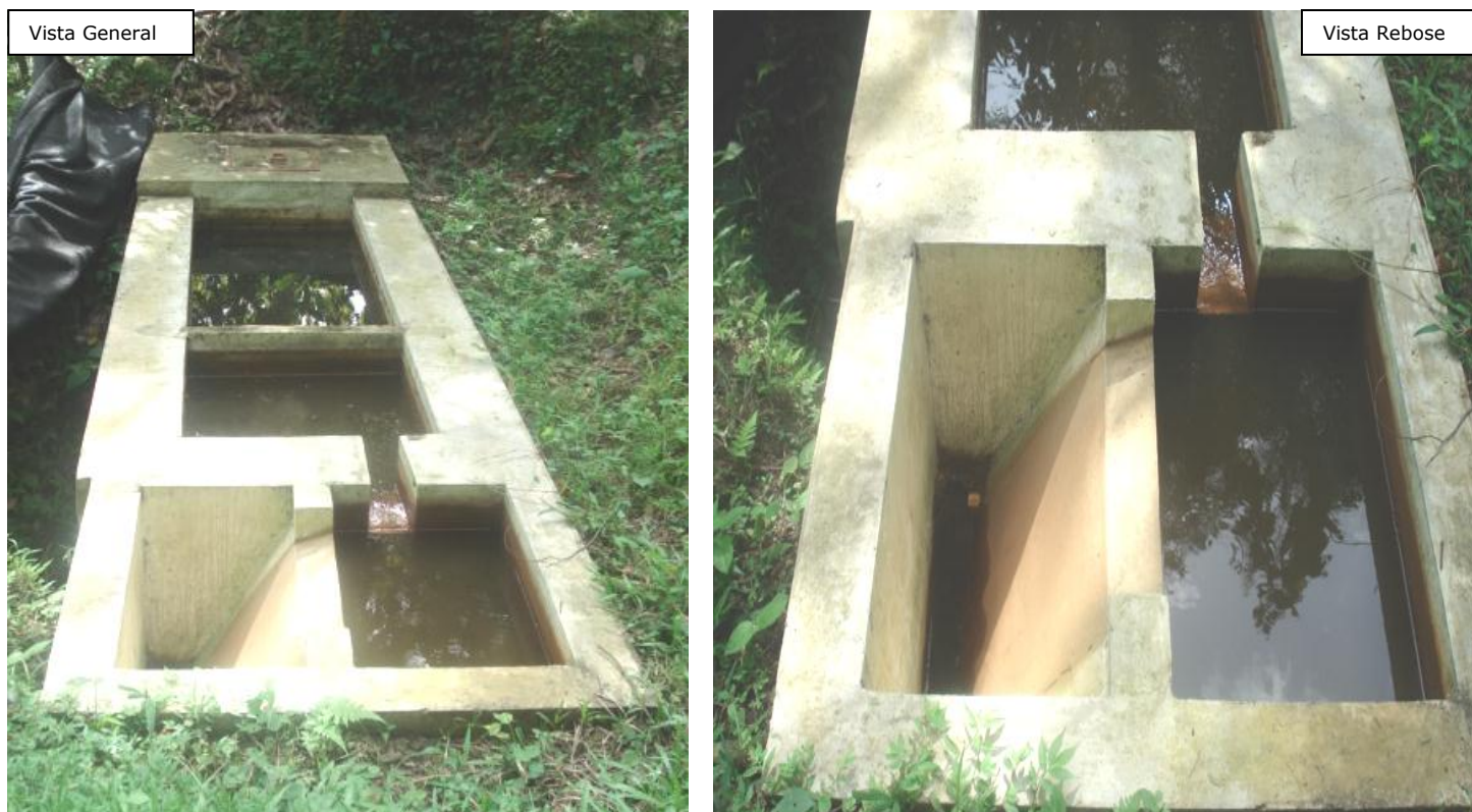
FIG No 16: Detalles Sedimentador La Esperanza
