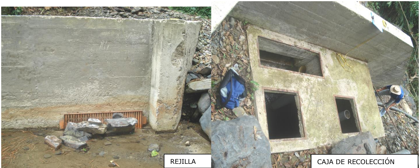
FIG No 11: Detalles de la Bocatoma Los Lirios
