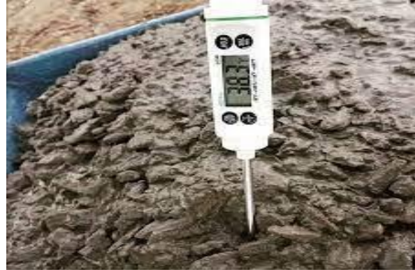
Figura 16. Temperatura de concreto fresco.
