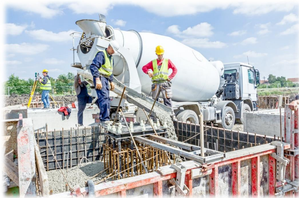
Figura 13. Enfriamiento del concreto vaciado en altas temperaturas
