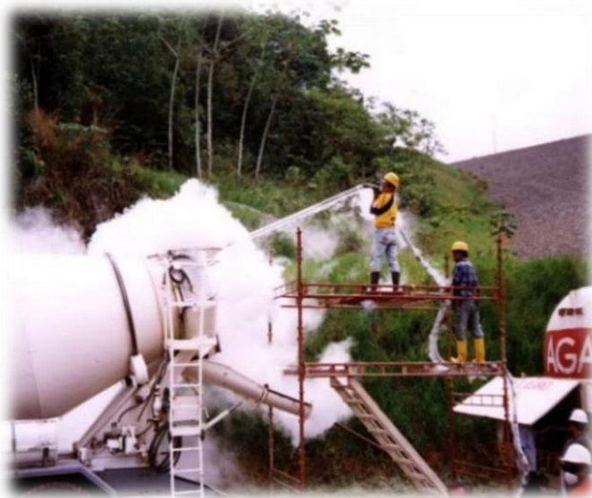
Fuente: Control de las Temperaturas en el Concreto. Fuente: Asocreto (s.f)
