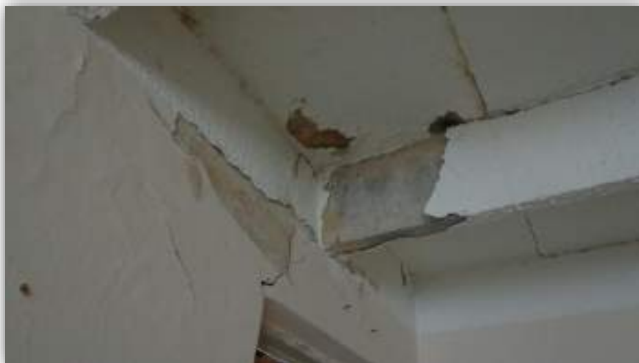
Figura 24. Sistema de Placa Prefabricada Dilatada.
