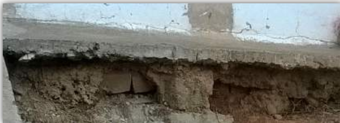
Figura 18. Estado Actual Cimentación de la Casa.
