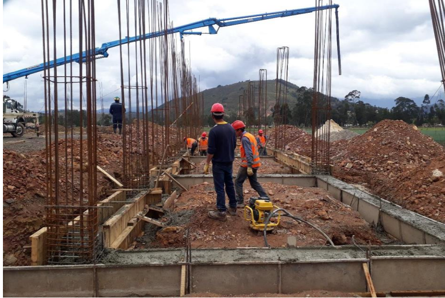
Ilustración 25. Vaciado de concreto premezclado
