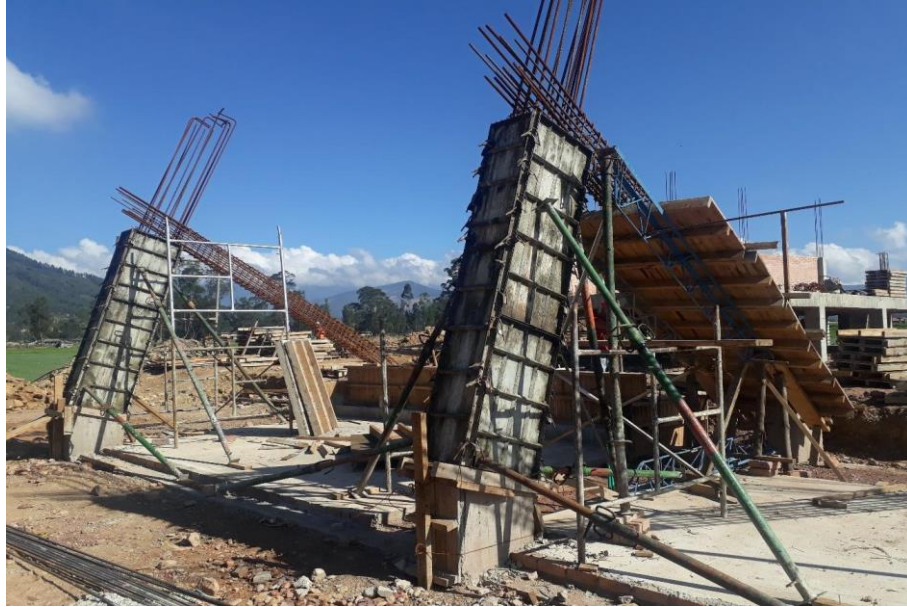
Ilustración 33. Instalación formaleta columnas.
