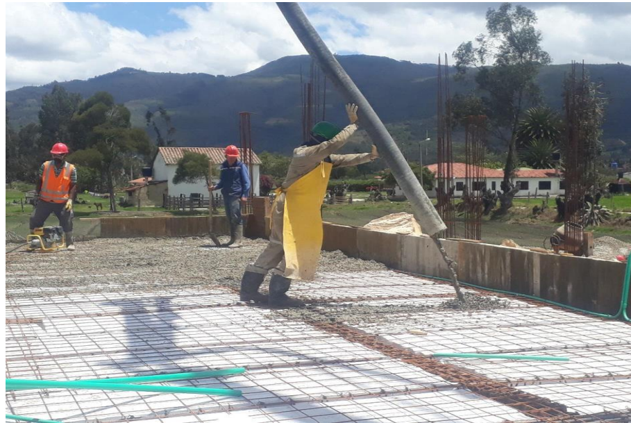
Ilustración 36. Vaciado concreto premezclado.
