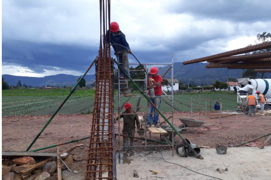
Ilustración 34. Vaciado y vibrado del concreto columnas.
