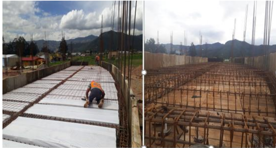
Ilustración 35. Modelo constructivo placa aligerada.
