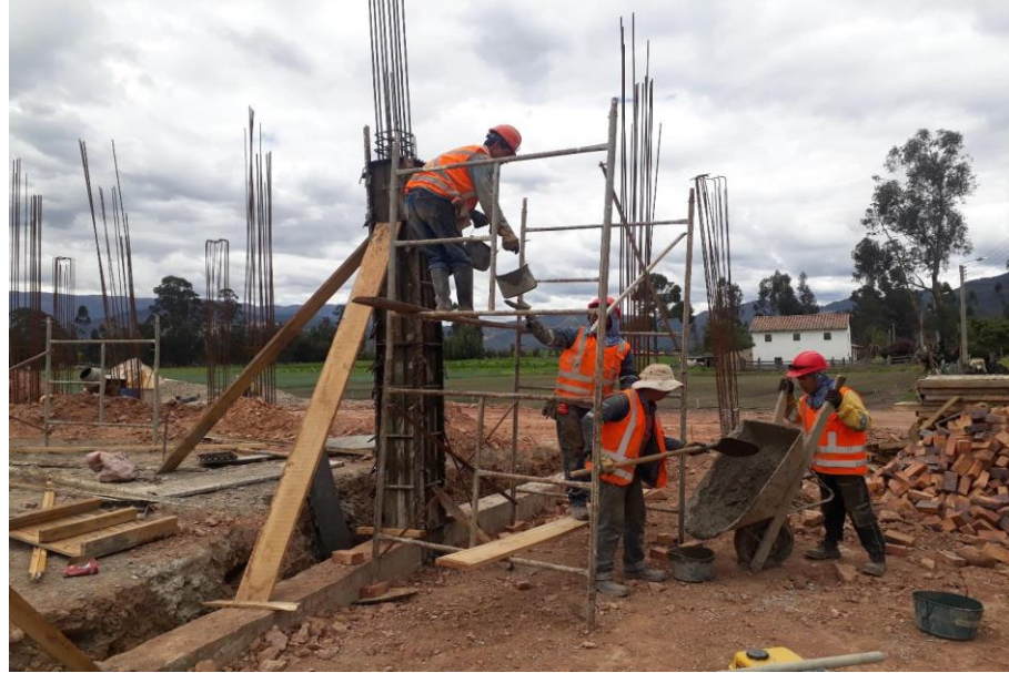
Ilustración 30. Vaciado de concreto.
