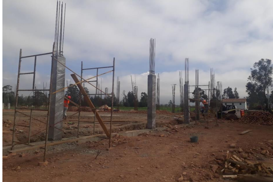
Ilustración 31. Desencofrado
