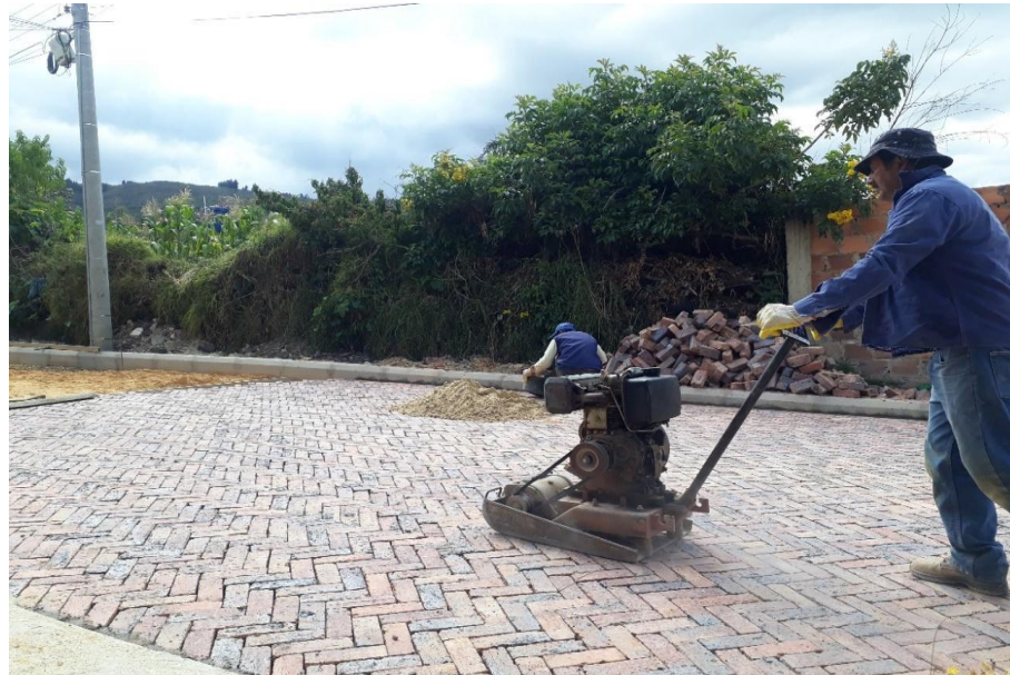
Ilustración 13. Compactación mediante vibro-compactador en la carrera 12 entre calles 3 y proyección calle1
