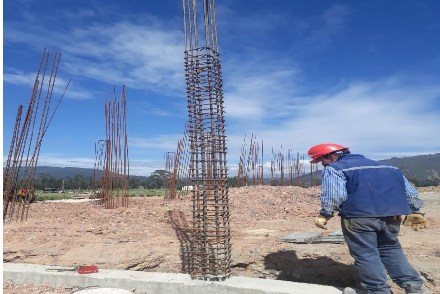
Ilustración 28. Refuerzo vertical columnas
