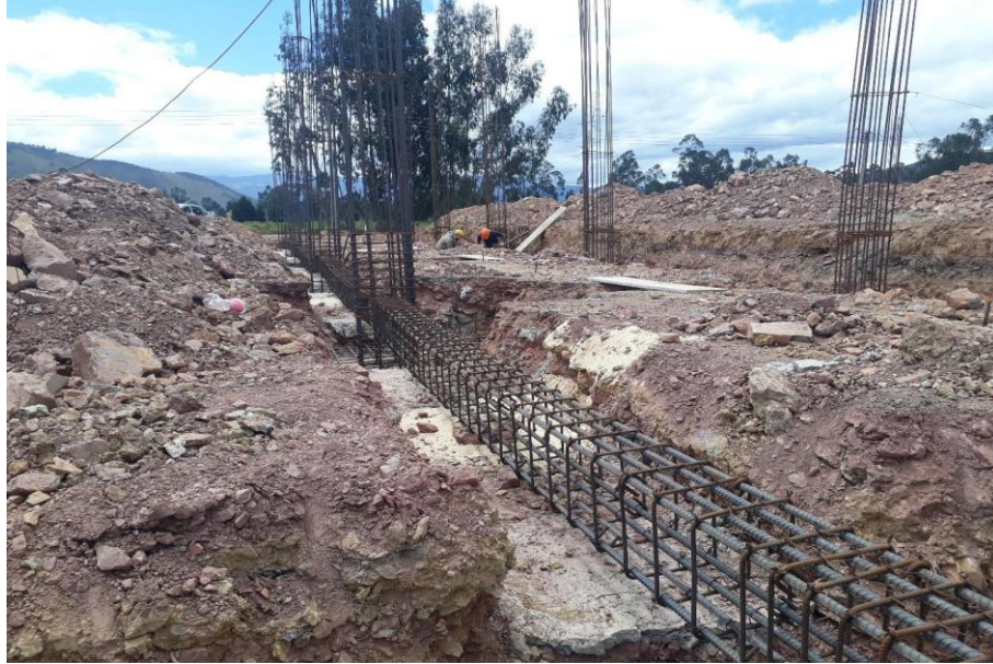
Ilustración 24. Armadura viga cimentación
