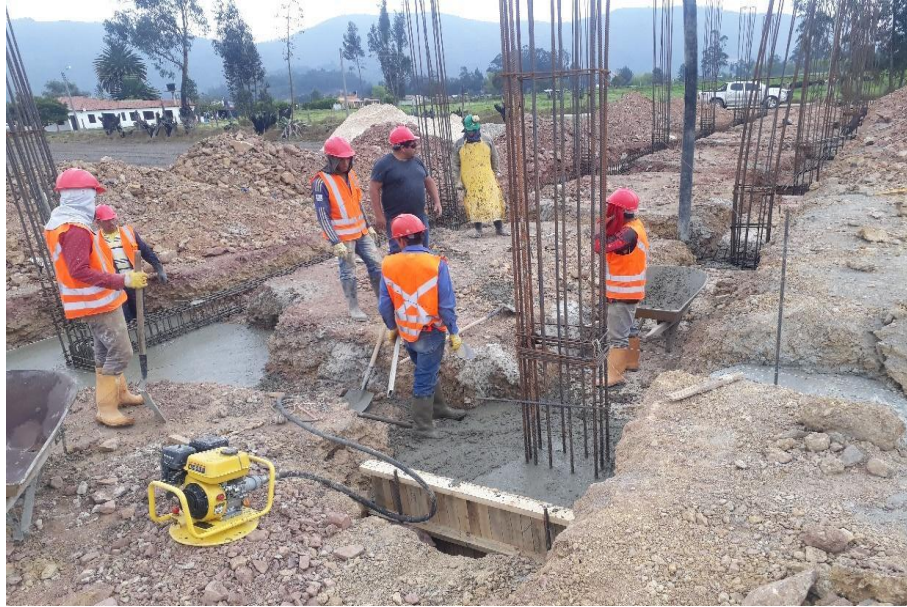
Ilustración 20. Vaciado de concreto premezclado.
