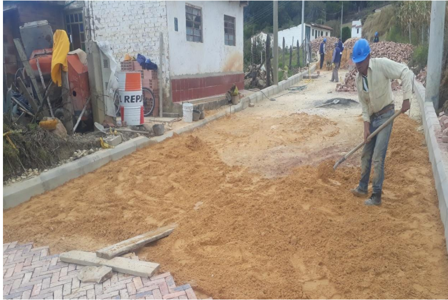
Ilustración 5. Cama de arena en la carrera 12 entre calles 3 y proyección calle 1.
