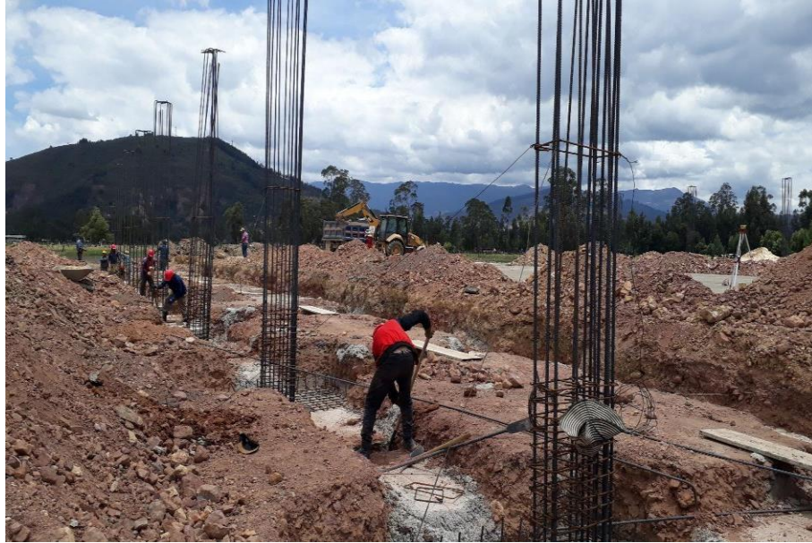
Ilustración 22. Excavación vigas cimentación
