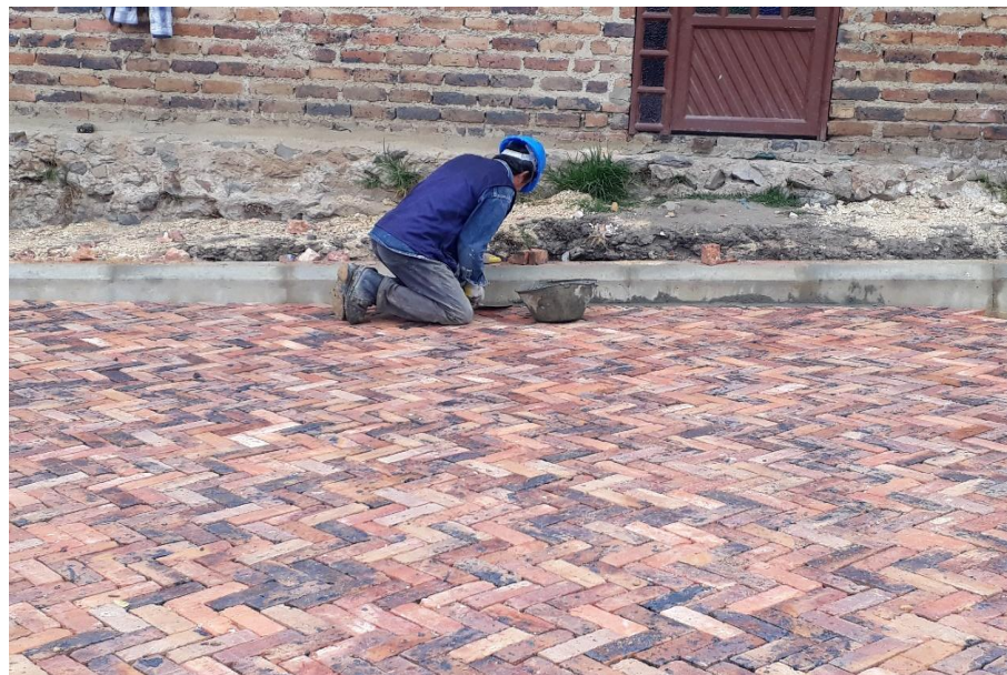
Ilustración 10. Confinamiento interno en calle 1 entre carreras 8 y 9.
