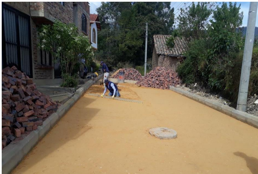
Ilustración 6. Nivelación de área según cotas y pendientes en calle 1 entre carreras 8 y 9.
