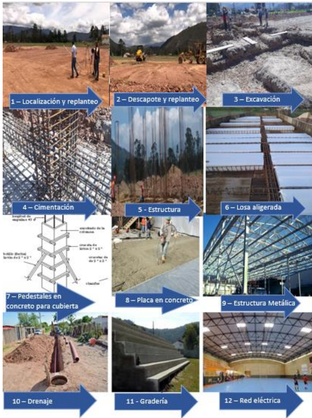
Ilustración 16. Resumen proceso constructivo.
