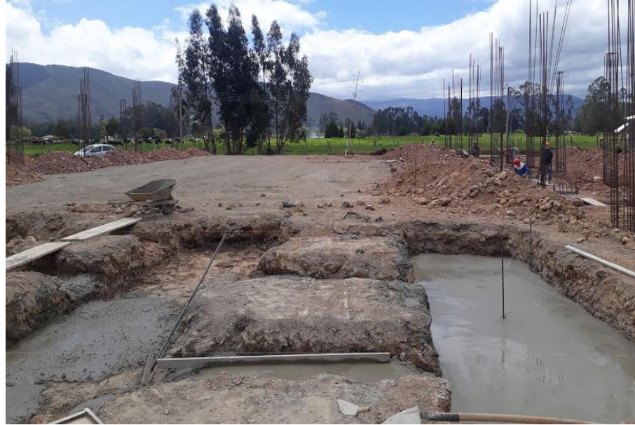
Ilustración 18. Solado en zapatas
