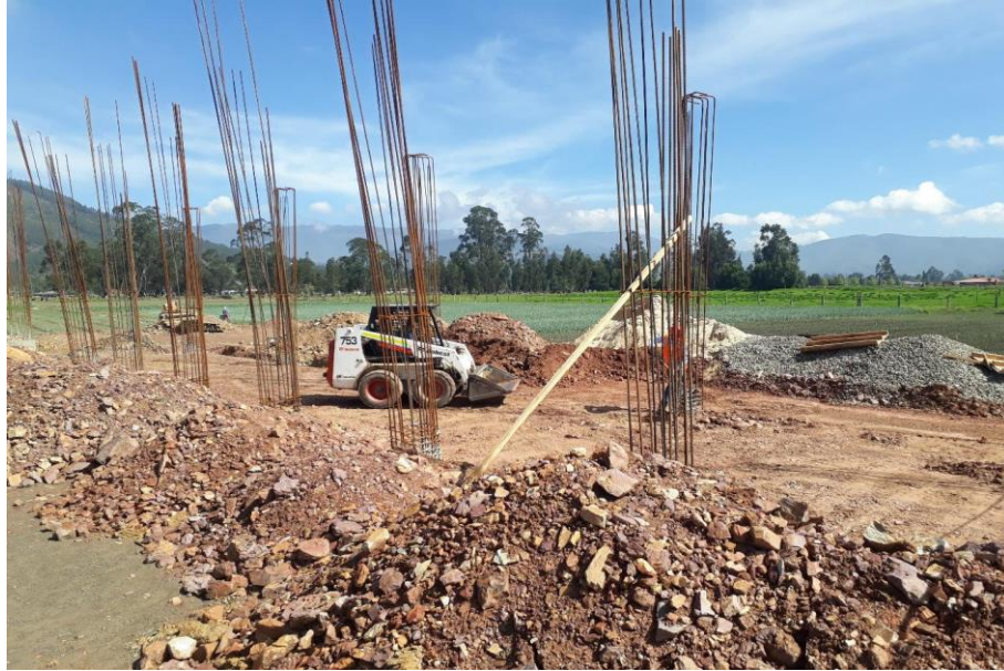
Ilustración 27. Relleno con material de afirmado.
