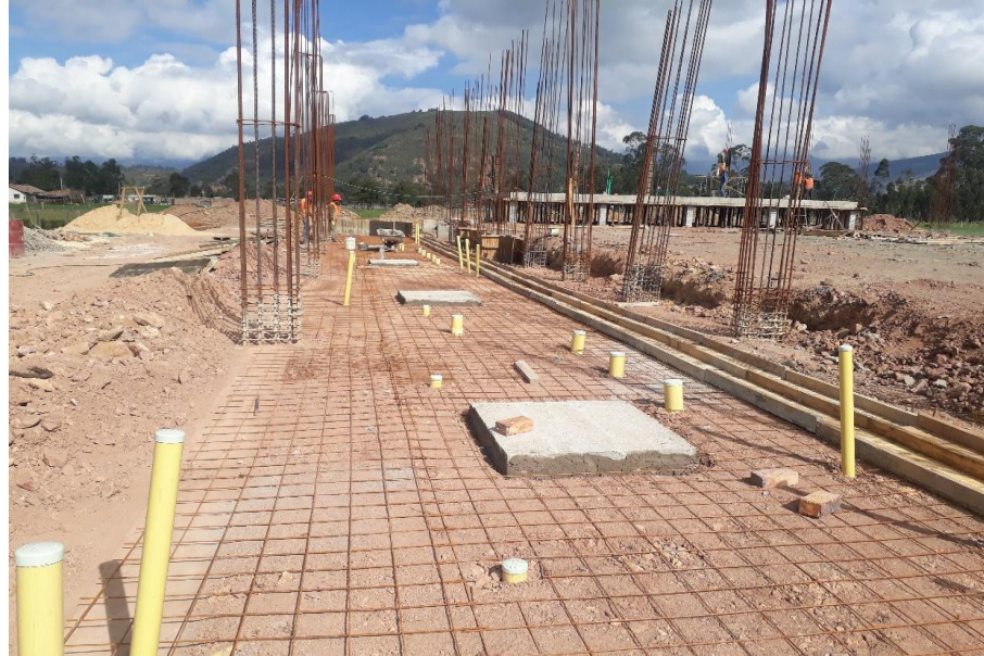
Ilustración 37. Instalación malla electrosoldada.
