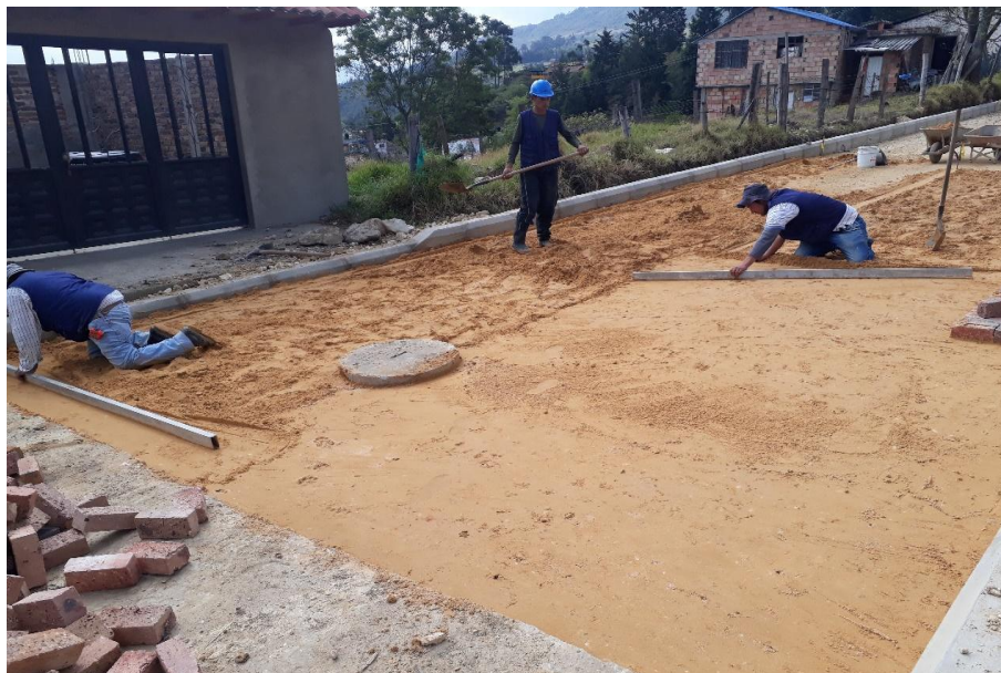
Ilustración 7. Nivelación de área según cotas y pendientes en la carrera 12 entre calles 3 y proyección calle.
