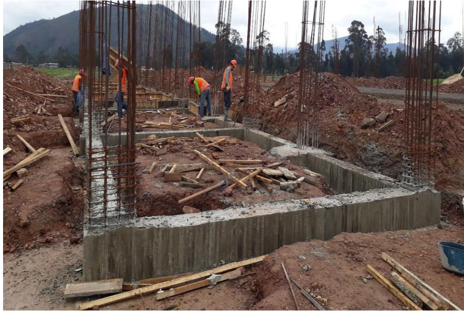
Ilustración 26. Desencofrado y curado de concreto
