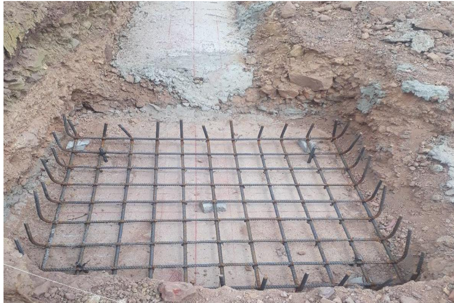
Ilustración 19. Armadura zapata
