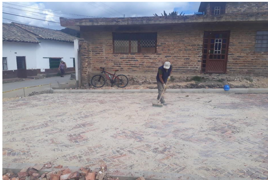
Ilustración 14. Sellado de juntas calle 1 entre carreras 8 y 9.
