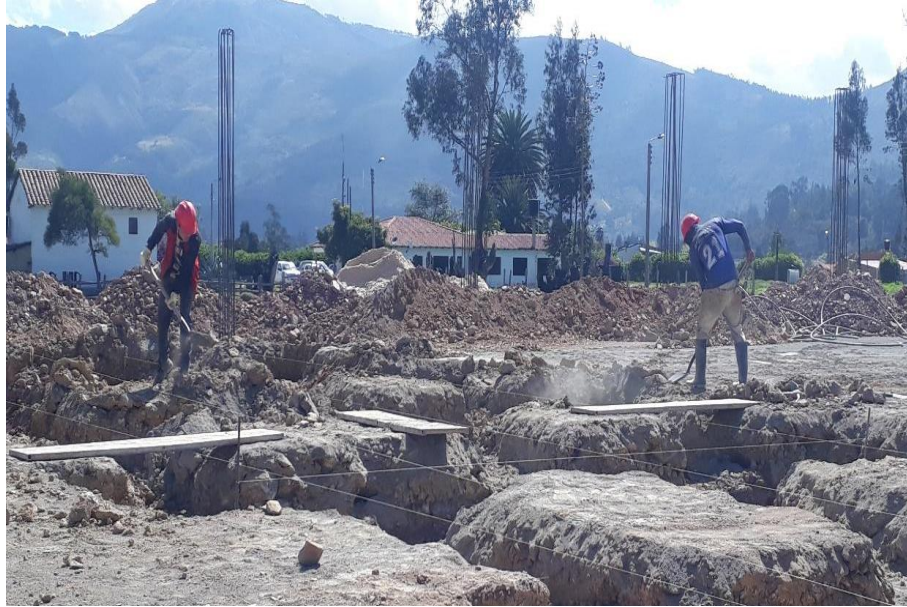
Ilustración 17. Excavación manual.
