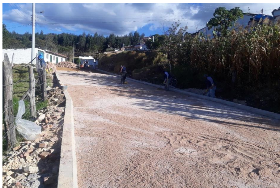
Ilustración 15. Sellado de juntas en la carrera 12 entre calles 3 y proyección calle1.
