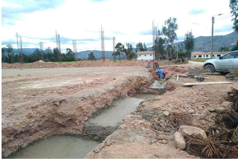
Ilustración 23. Solado en concreto vigas.
