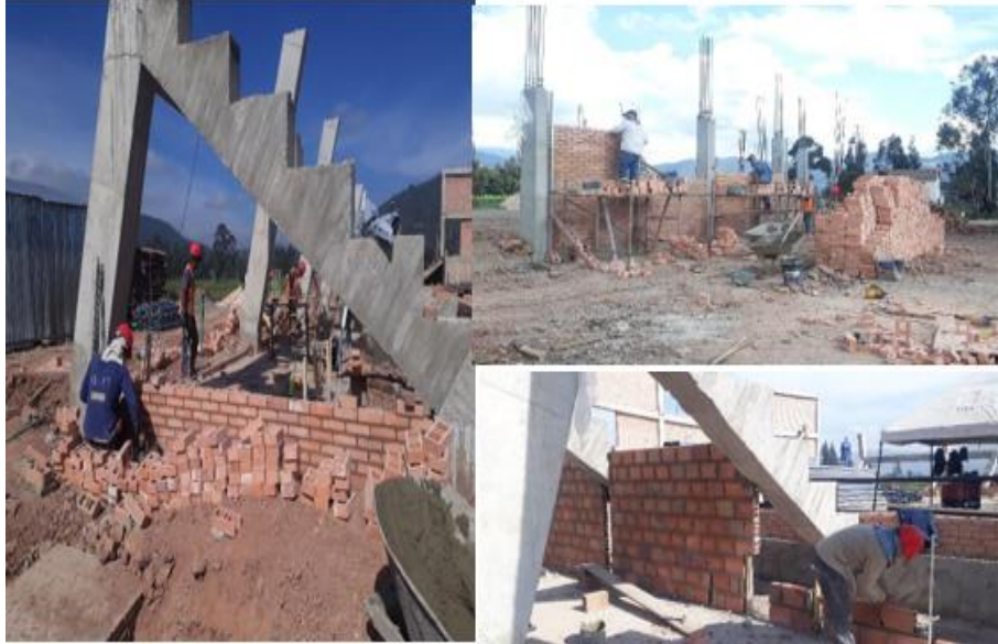
Ilustración 39. Muros en mampostería.
