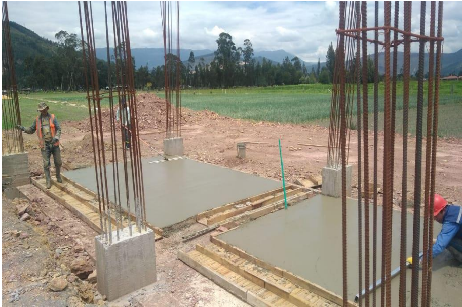
Ilustración 38. Instalación malla electrosoldada
