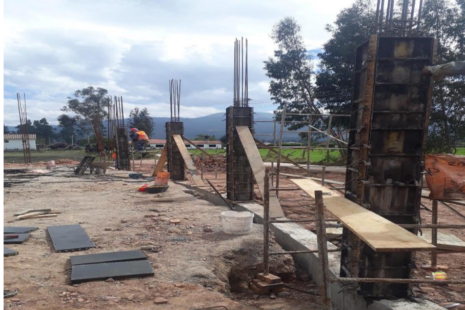
Ilustración 29. Instalación Formaleta metálica.
