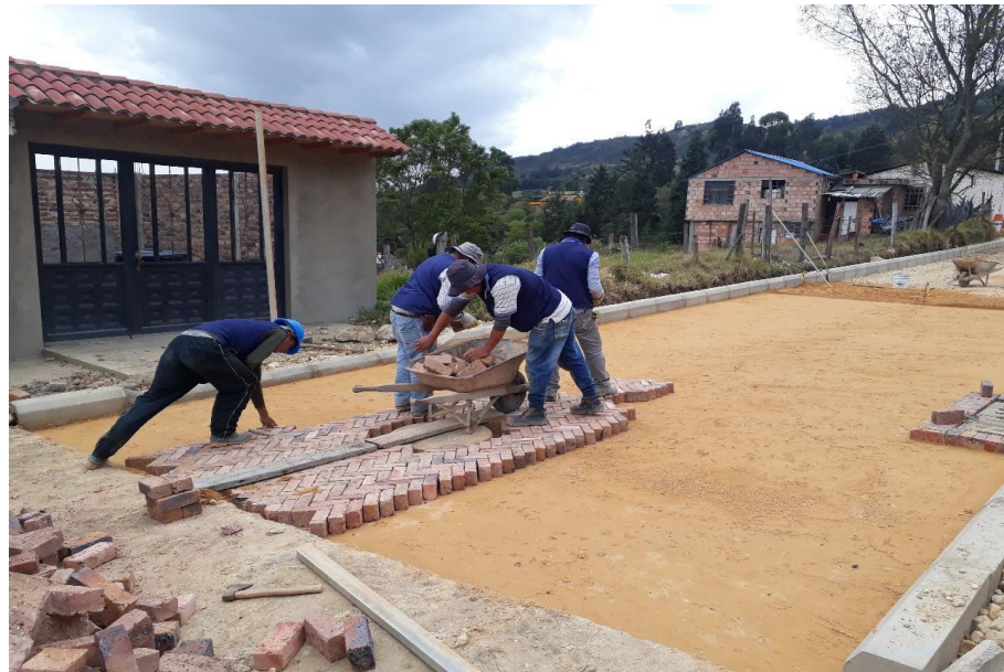
Ilustración 9. Colocación adoquín patrón espina de pescado en la carrera 12 entre calles 3 y proyección calle1.
