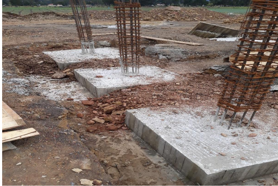
Ilustración 21. Desencofrado y curado de concreto.
