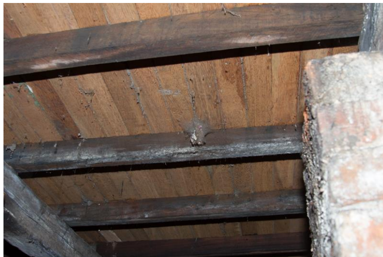
Estructura de soporte del piso del escenario
