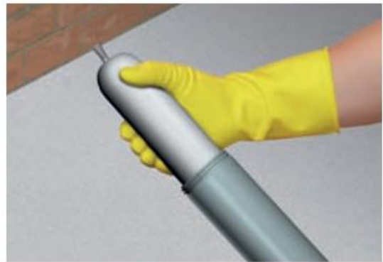
Insertar el salchichón de SikaMur®-InjectoCream-100 dentro de la pistola
