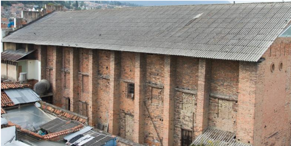
Figura 135 Fachada lateral sur
