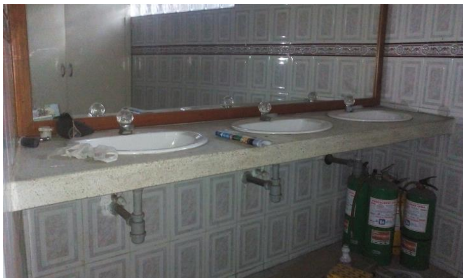
Figura 86 Zona de lavamanos
