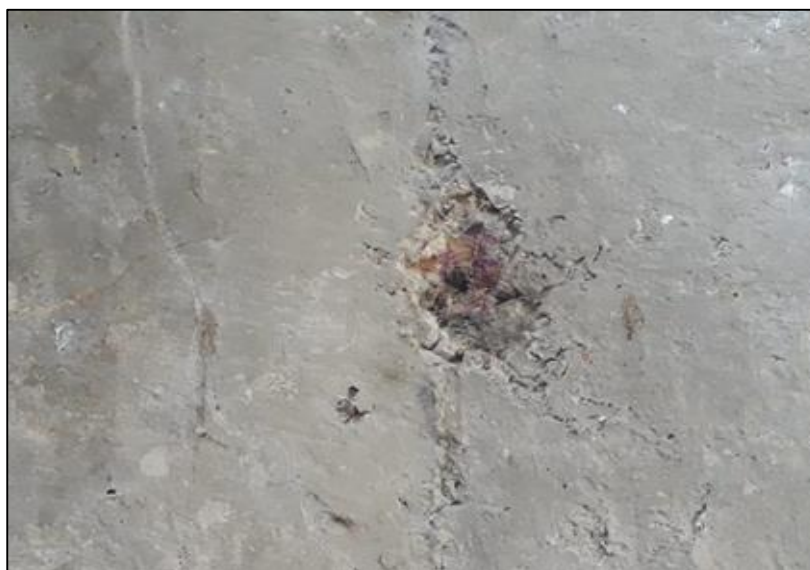
Figura 27 Detalle orificio Fuente: elaborado por el autor
