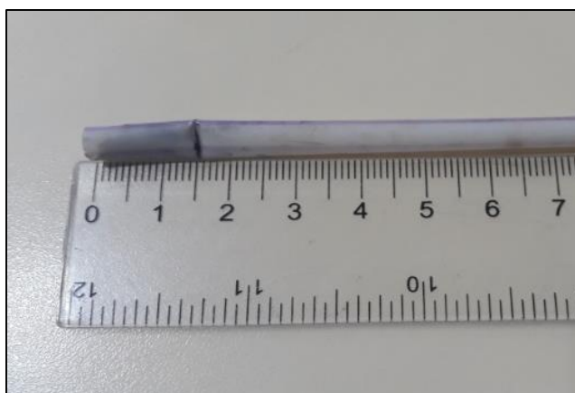
Figura 23 Profundidad de carbonatación: 15mm Fuente: elaborado por el autor
