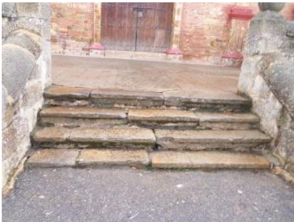
Fotografía 16: Escaleras de acceso templo doctrinero
