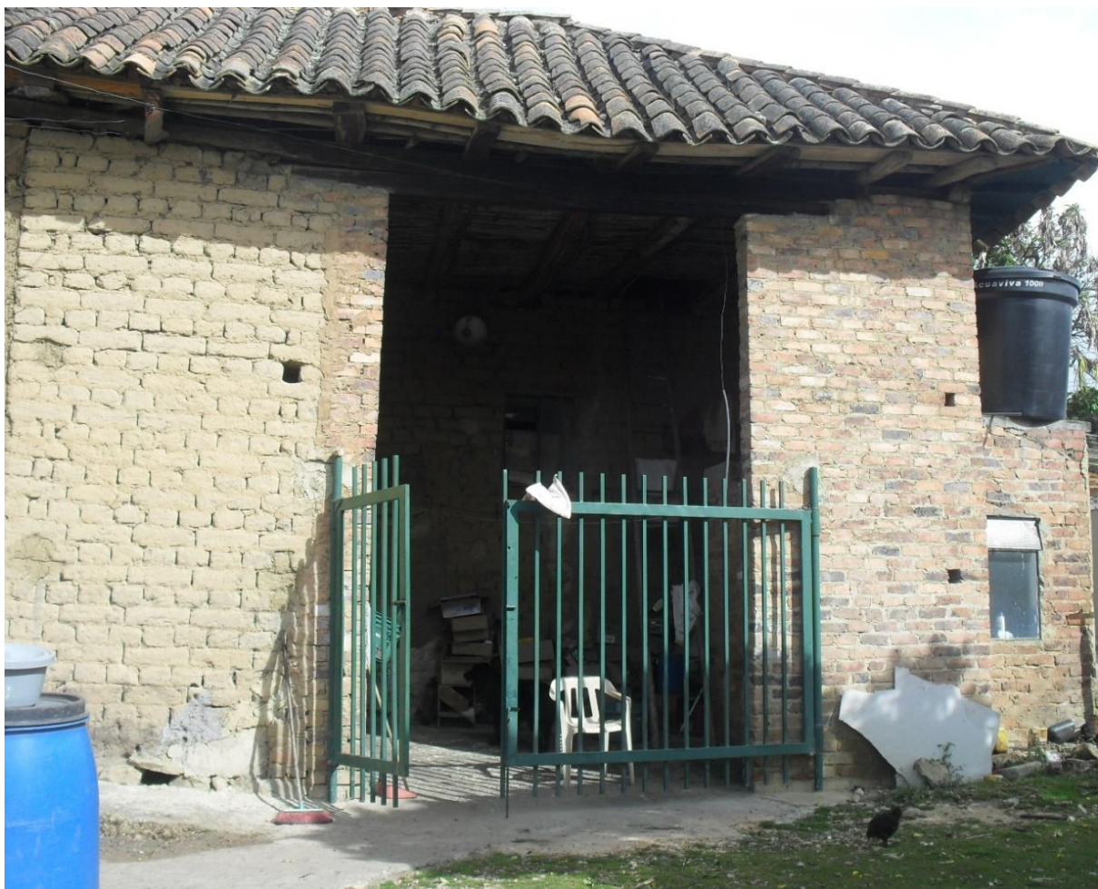
Fotografía 33: Casa Colonial Esquina, Chivatá, fachada posterior.
