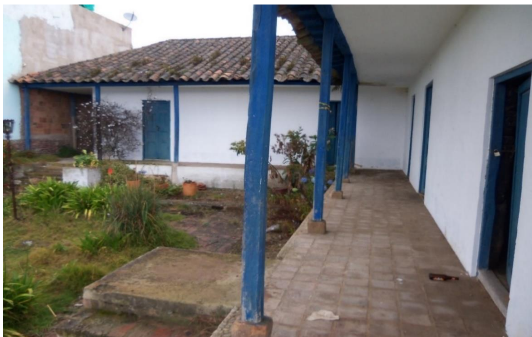
Fotografía 38: corredor interior, casa esquina del parque.
