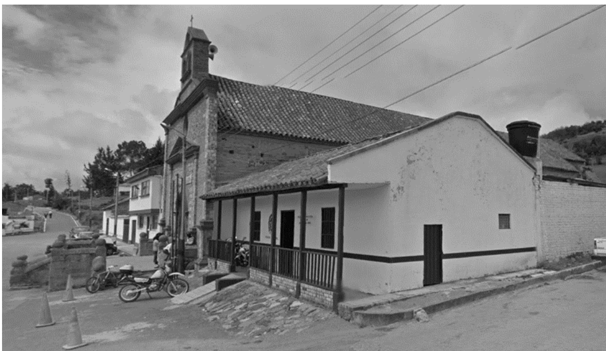
Fotografía 26: Casa Esquina Manzana 1, Chivatá
