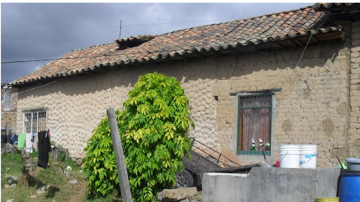
Fotografía 32: Casa Colonial Esquina, Chivatá, fachada posterior.
