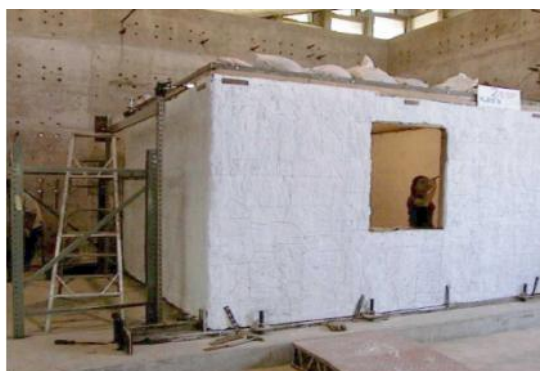
Ilustración 7 Construcción de muros en bahareque encementado y ensayo al aplastamiento sometidos a cargas verticales
