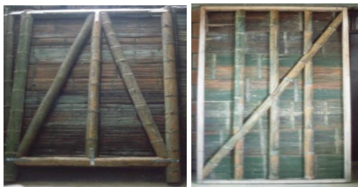
Ilustración 6 Construcción de muros en guadua y esterilla de guadua.
